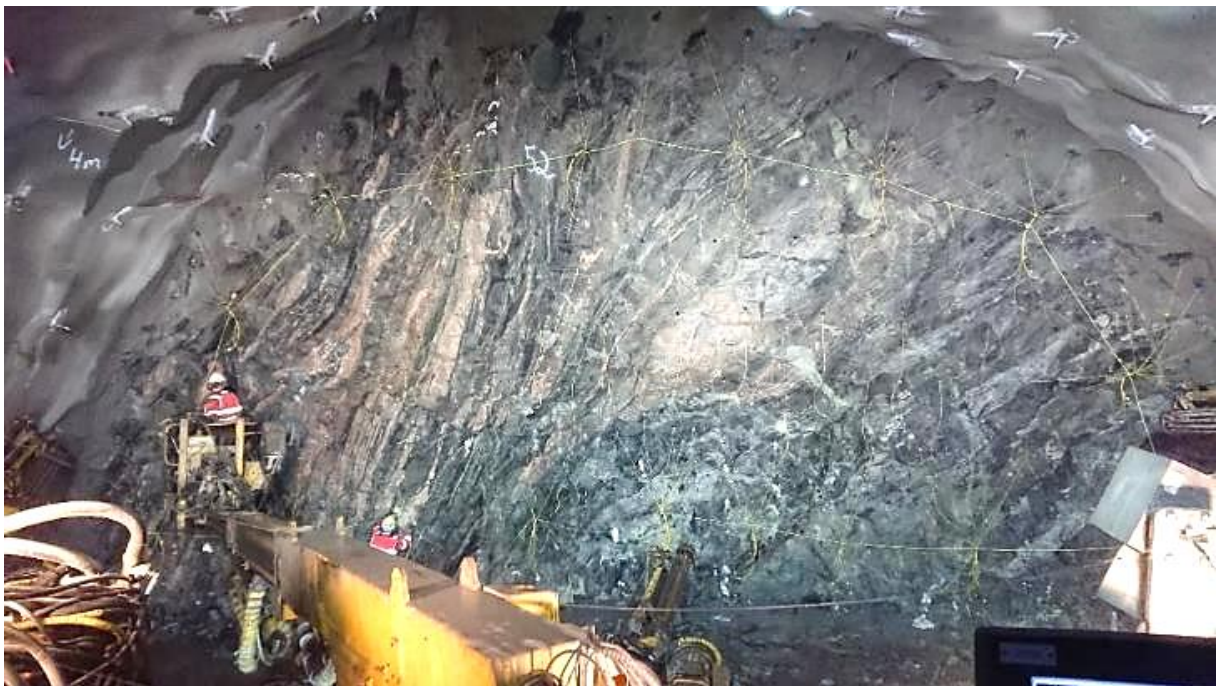
Figur 3 - Foto av stuff under lading, tatt fra hytta på borrygen
