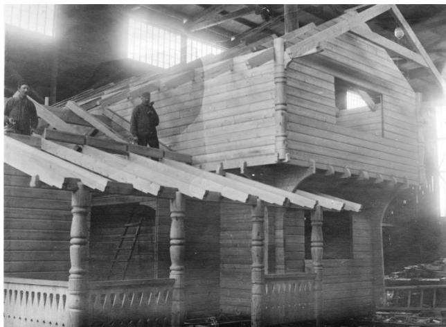
Figur 2: Laftehus under montering i tømmermannshallen på Strømmen (Foto: Akershusbasen 0231-124:0003)
