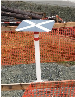
Figur 16: Grunnlagsnettpunkt med påmontert markør
