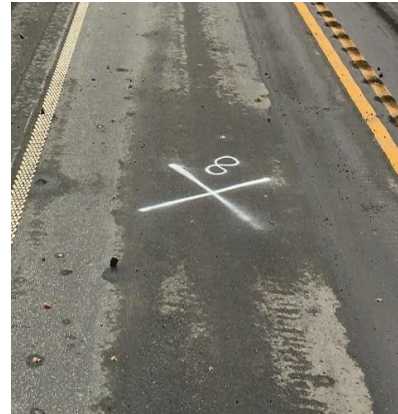
Figur 17: RTK målt punkt spraymalt direkte på bakken
