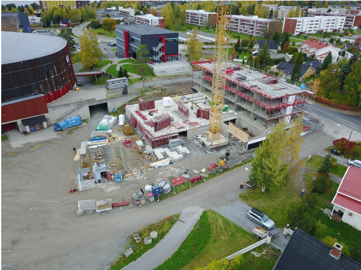
Figure 7 Råbygget er på vei opp. Riggplass tar opp mye areal (Liangen, 2019c).
