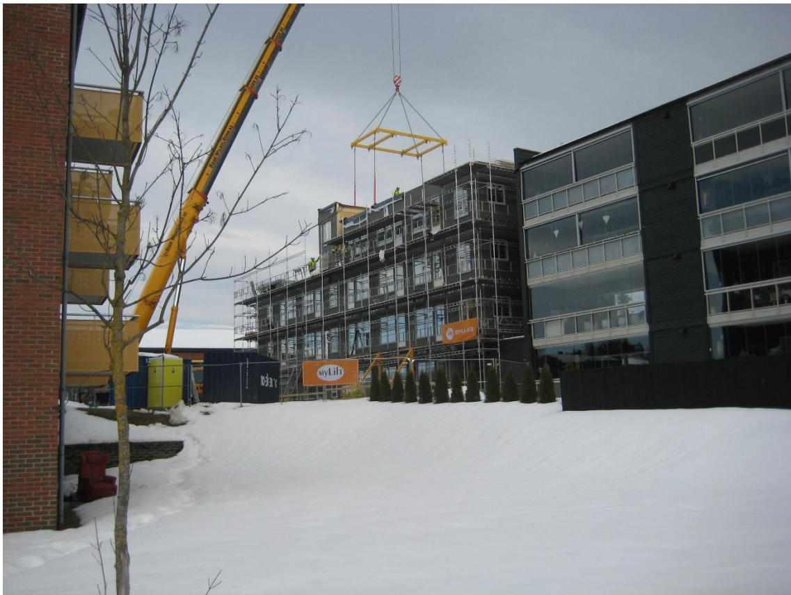
Figure 8 Heising av moduler. (Østby, 2019b)
