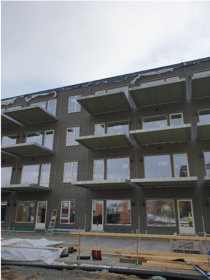
Figure 9 Etterarbeid av modulene etter heising. (Østby, 2019c)
