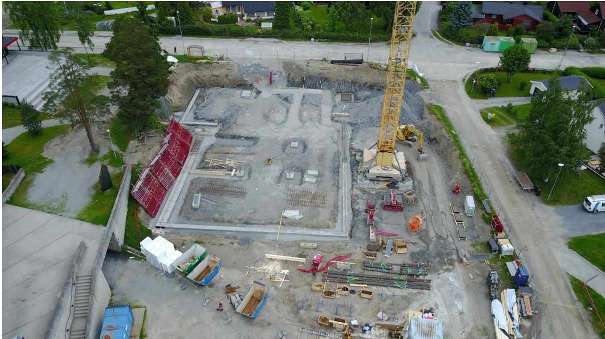
Figure 2 Byggeplassen etter at fundament er ferdigstøpt. Ser konturene av hvor mye plass riggplassen tar (Liang, 2019b).
