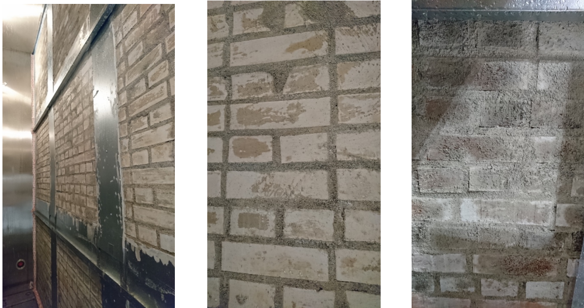
Figur 10: Viser veggfeltene på utvendig/kald side av klimasimulatoren. Bilde i midten viser et veggfelt med gul teglstein og bilde til høyre viser rød teglstein.
