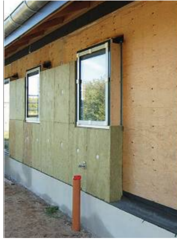
Figur 2.4: Utvendig rehabilitering med Rockwool sitt isolasjonssystem for effektiv isolasjon uten kuldebroer (Rockwool, 2019).
