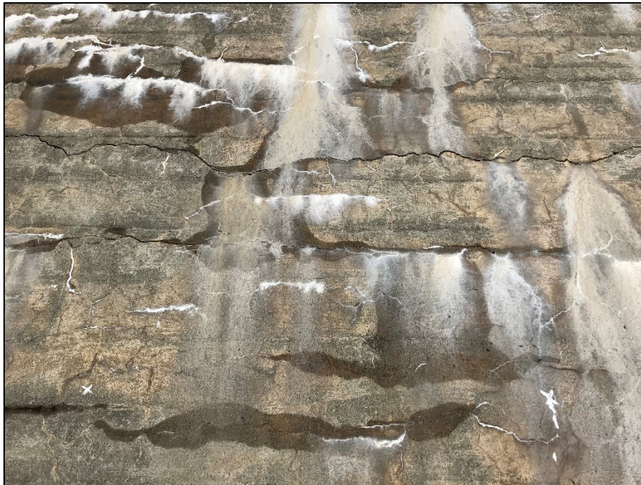
Figur 7-2: Nedstrømsside av Tyin Dam 3
