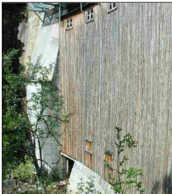
Figur 7-6: Oppvarma isolasjonsvegg i treverk (Rodum et al., 2004)
