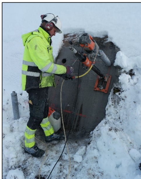
Figur 3-9: Oppsett av borerigg
