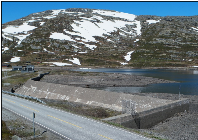
Figur 7-7: Oversiktsbilde av Tyin Dam 1
