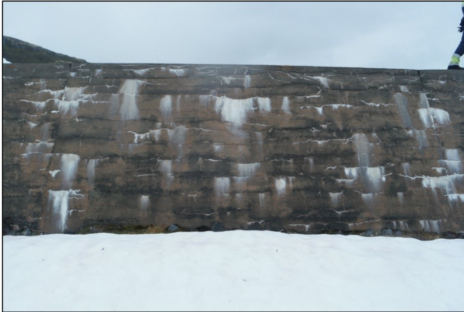
Figur 3-3: Krakeleringmønster grunna alkalireaksjon
