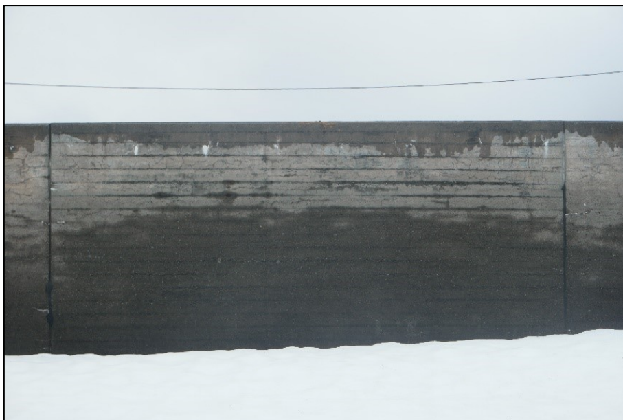
Figur 7-3: Oppstrømsside av Tyin Dam 3
