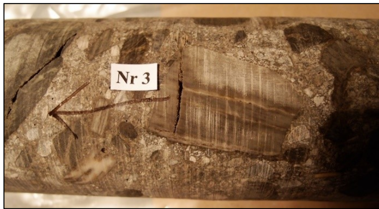
Figur 5-3: Riss gjennom tilslag, prøve nr. 3
