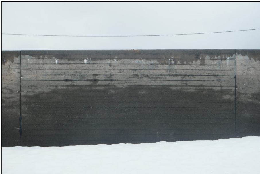
Figur 3-4: Oppstraumsside Tyin Dam 3
