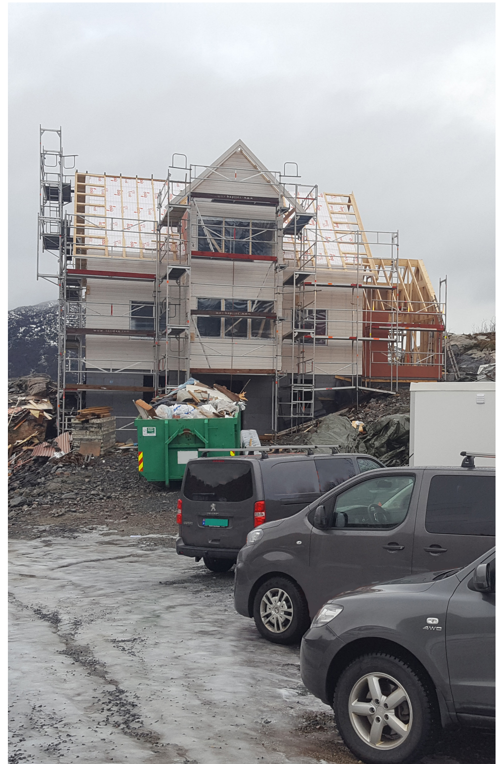
Figur 10: Anleggsområde som ble besøkt under innsiktfasen.
