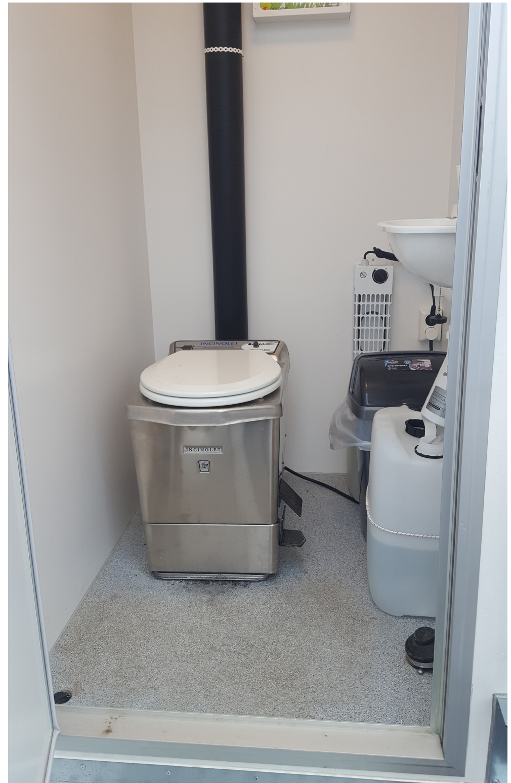
Figur 11: Incinolett i arbeidsbrakke.
