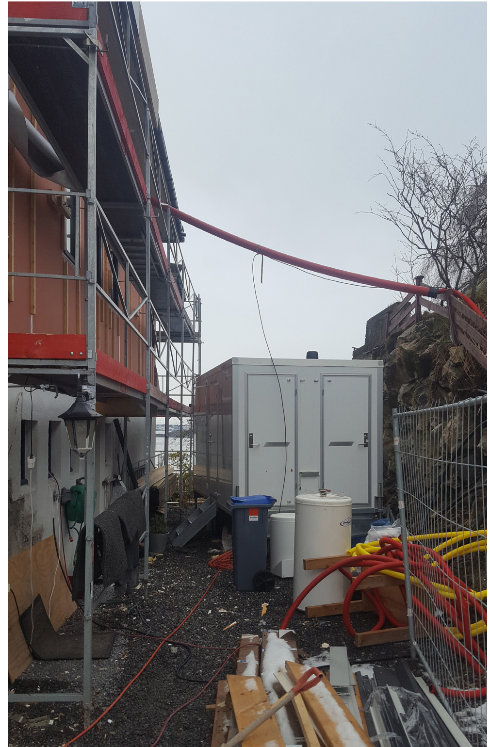
Figur 7: Toalettbrakke ved anleggsområde.
