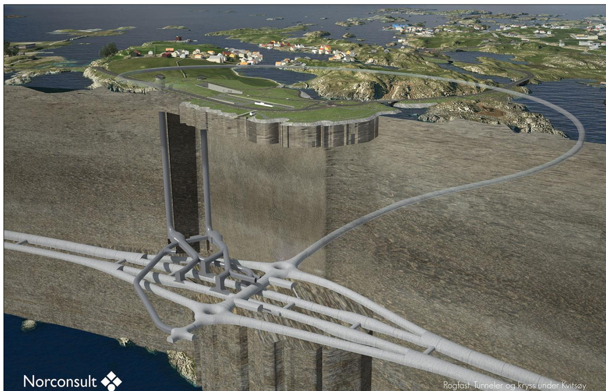
Figur 1.2: 3D-modell av Kvitvøy-tunnelen og kryssområdet under Kvitvøy. Illustrasjon: Norconsult AS.
