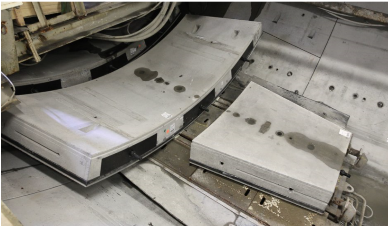
Figur 7.1: Fotografi av et standard betongsegment (til venstre) og et nøkkelsegment (til høyre). En ring av betongutforingen består av flere betongsegmenter og et nøkkelsegment. Foto: Sandness (2018) .
