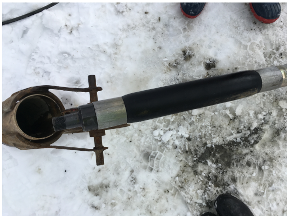
Figur 4. Pakker, som skal sørge for at vannet går inn i sprekkene i bergmassen og ikke opp igjen til overflaten. Pakkeren blåses opp under høyt trykk. Bilder tatt i felt, fra Follobanen.
