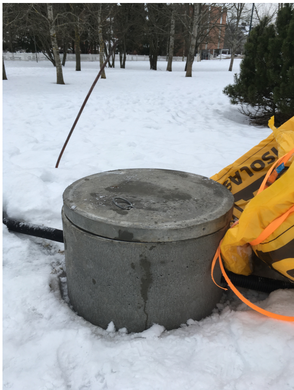
Figur 35. Infiltrasjonsbrønn på Follobanen. a) Brønnhus. b) Infiltrasjonsbrønn, ventiler, klokker som viser trykk og infiltrasjonsmengder, kobling til det offentlige drikkevannsnettet.
