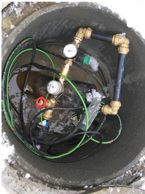
Figur 35. Infiltrasjonsbrønn på Follobanen. a) Brønnhus. b) Infiltrasjonsbrønn, ventiler, klokker som viser trykk og infiltrasjonsmengder, kobling til det offentlige drikkevannsnettet.
