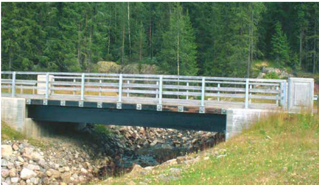
Figur 1 - Grylla bru er et eksempel på ei bru med tverrspent dekke [4]. Det tverrspente dekket kjennes igjen ved de jevnt plasserte stålstagene og forankringsplatene i bruas lengderetning.
