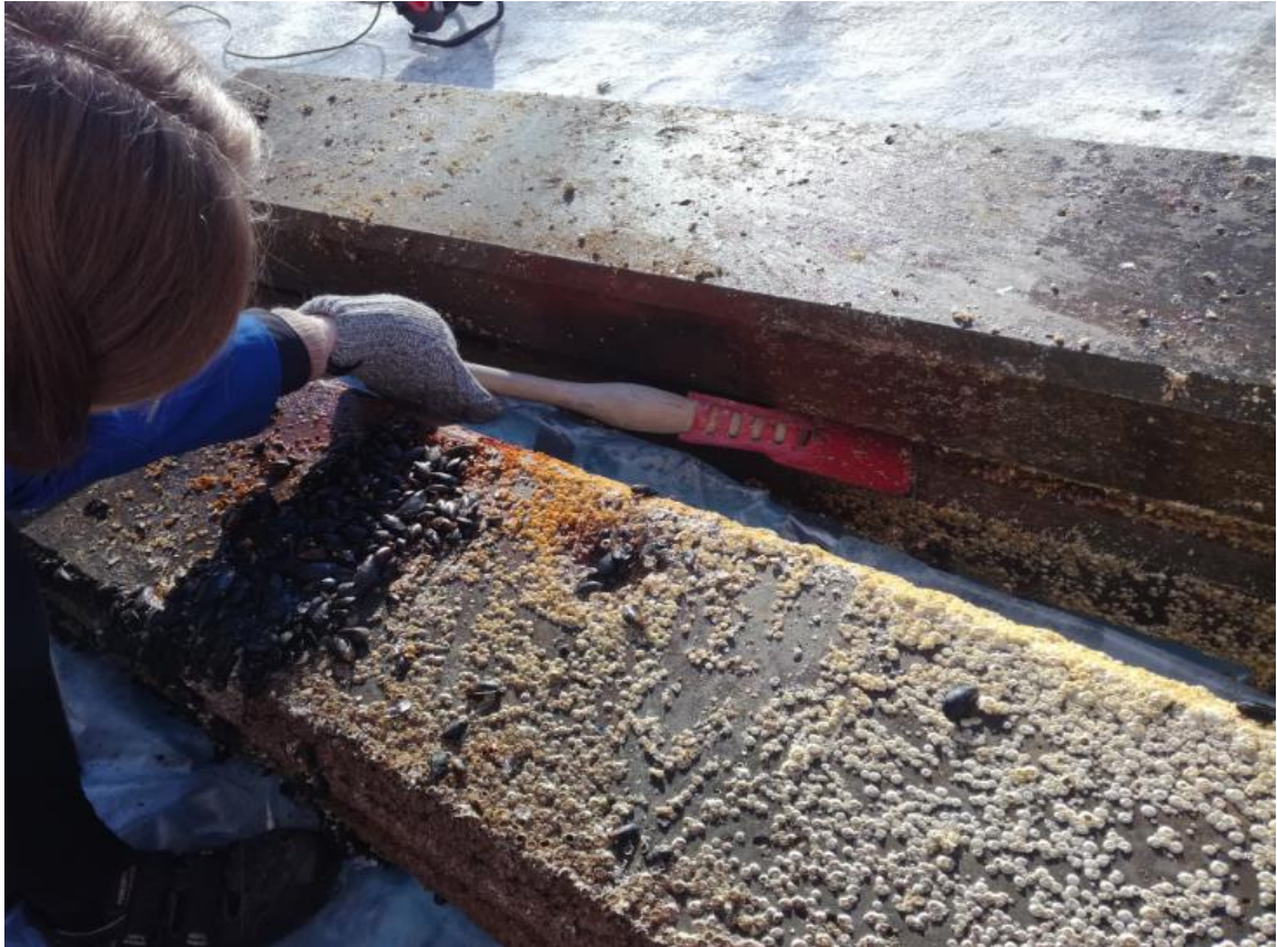
Figur 3.10: Bruk av stålskraper for å fjerne skjell på bjelkene. (Eget foto)
