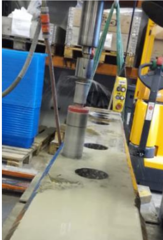
Figur 3.17: Utboring av kjerner med en vannkjølt betongbor. (Eget foto)
