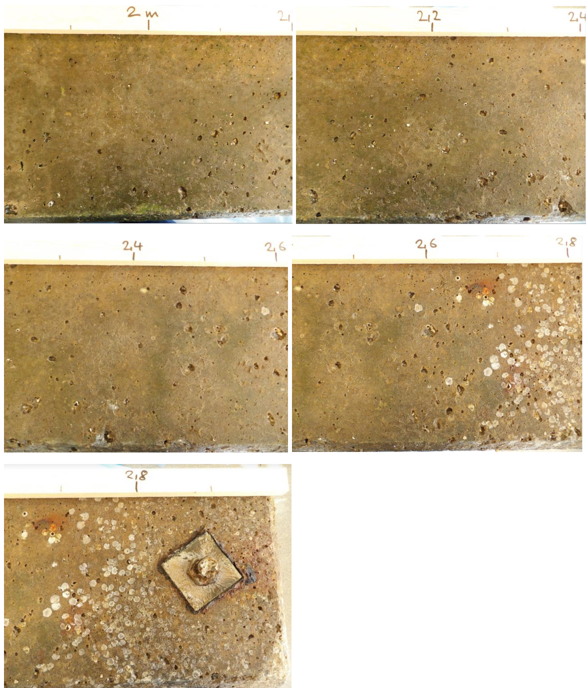
Figur E.2: Bilder av overflaten på bjelke B. Bildene er tatt fra atmosfæresonen ved start på 0 meter mot nedsenket sone. (Egne foto).
