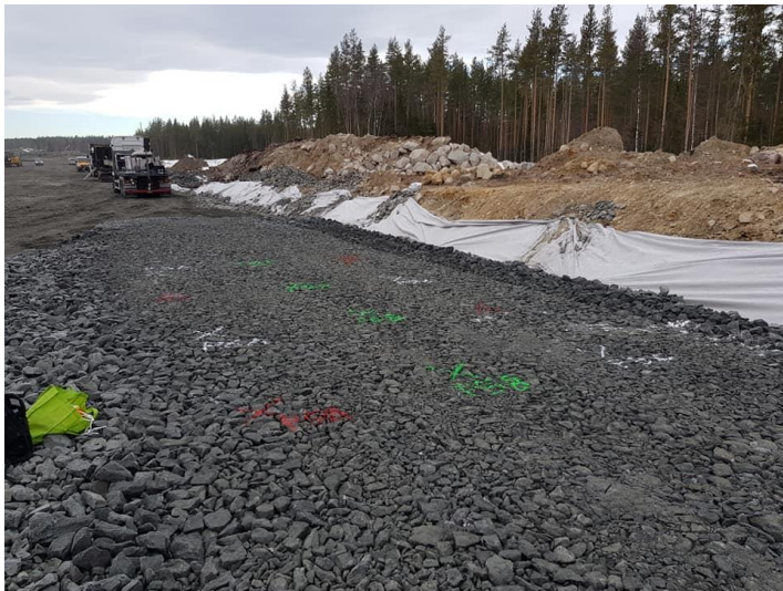
Figur 5: Ferdig utlagt og komprimert 20/120 FK forsterkningslag med testoppsett.
