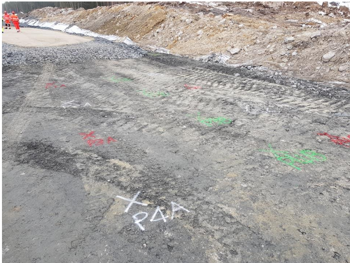
Figur 4: Ferdig utlagt og komprimert 0/300 FK frostsikringslag med testoppsett.
