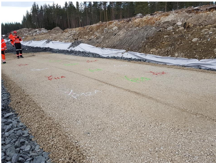
Figur 6: Ferdig utlagt og komprimert 0/32 FK forkilingslag med testoppsett
