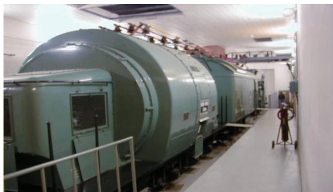
Figur 1: Roterende omformer [4]
