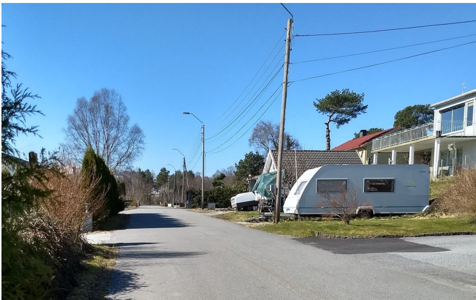
Figur 45. Gamle gatelys og luftspenn som skal skiftes ut sammen med VA-utbyggingsprosjektet
