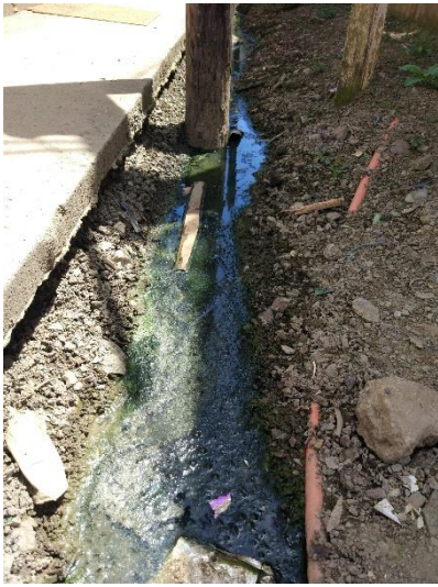
Avrenningsvann med preg av algevekst og olje.
