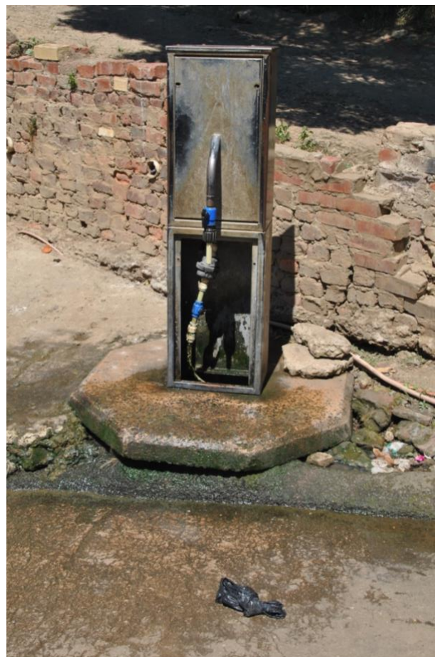
FIGUR 19 "STANDPIPE" VED KENNEDY ROAD SETTLEMENT. DURBAN, FEBRUAR 2019.
