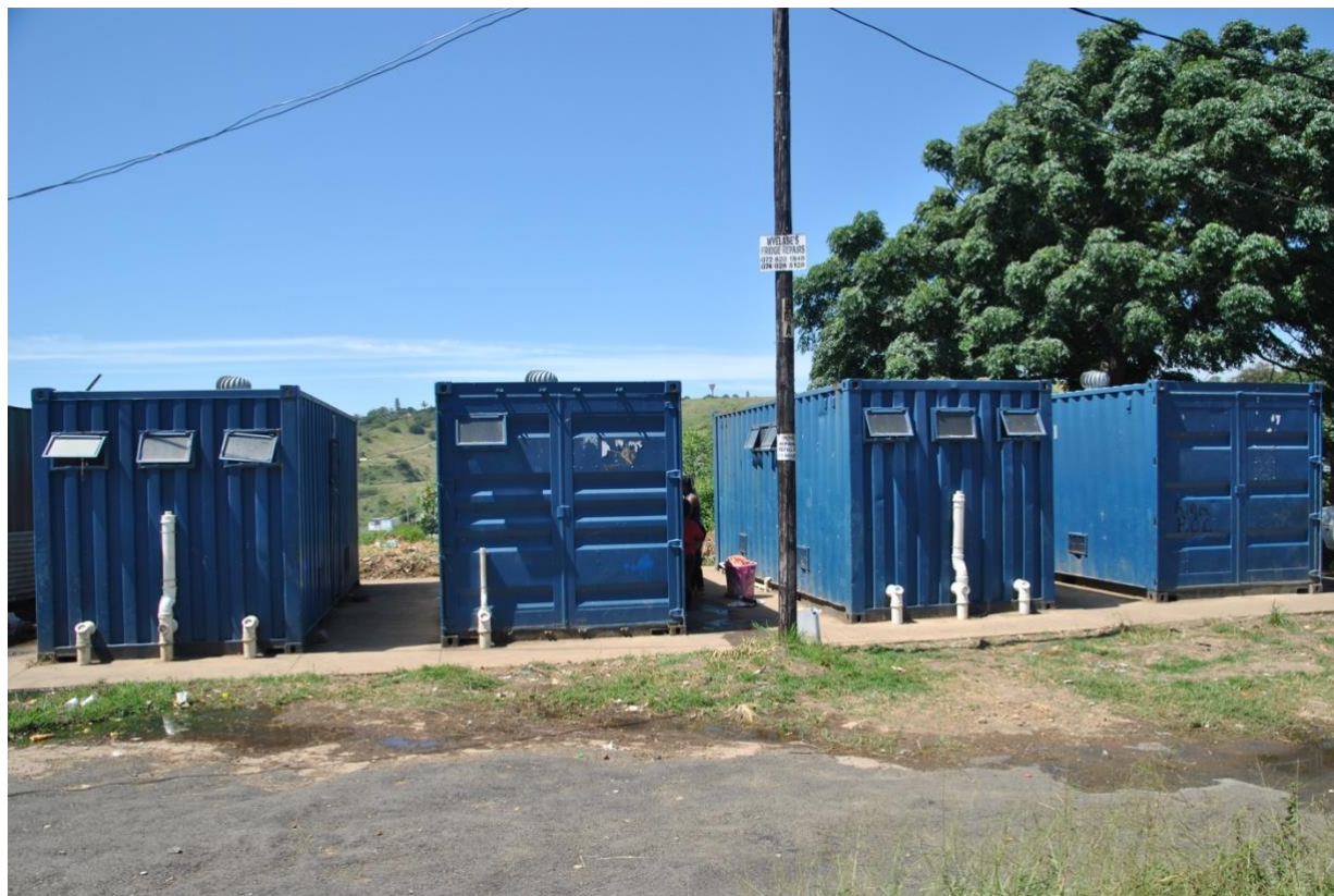
FIGUR 18 COMMUNITY ABLUTION BLOCKS VED KENNEDY ROAD. DURBAN, FEBRUAR 2019.
