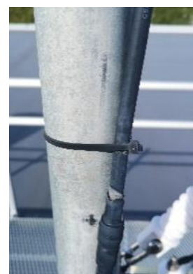
Figur 19 Sikring av kabel (foto: eget)
