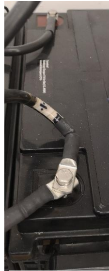
Figur 16 Poler fri for irr (foto: eget)
