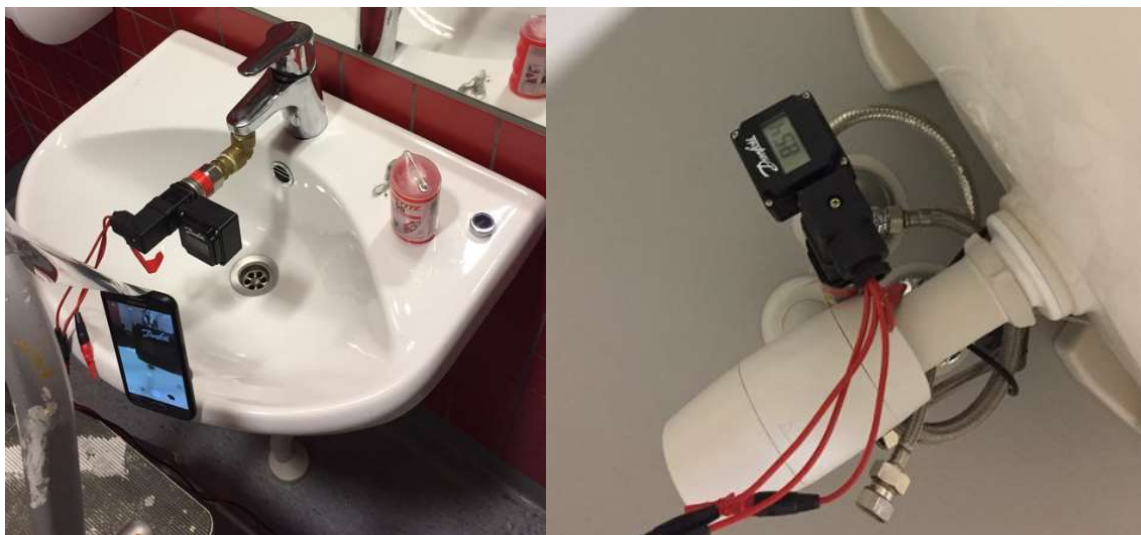
Figur 9: Måling av trykk i servant.
