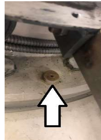
Figur 25 Plassering til vibrasjonssensor på turbinlaget ved Brattset
