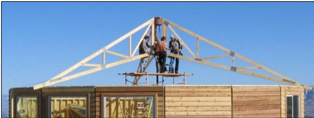
Figur 15: Installasjon, fagverksbjelker med ring. Bilde: Deltec Homes (2015b)
