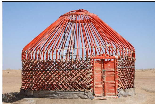
Figur 22: Eksempel på bæresystem med trykkring i en Yurt, Dalbéra (2011)
