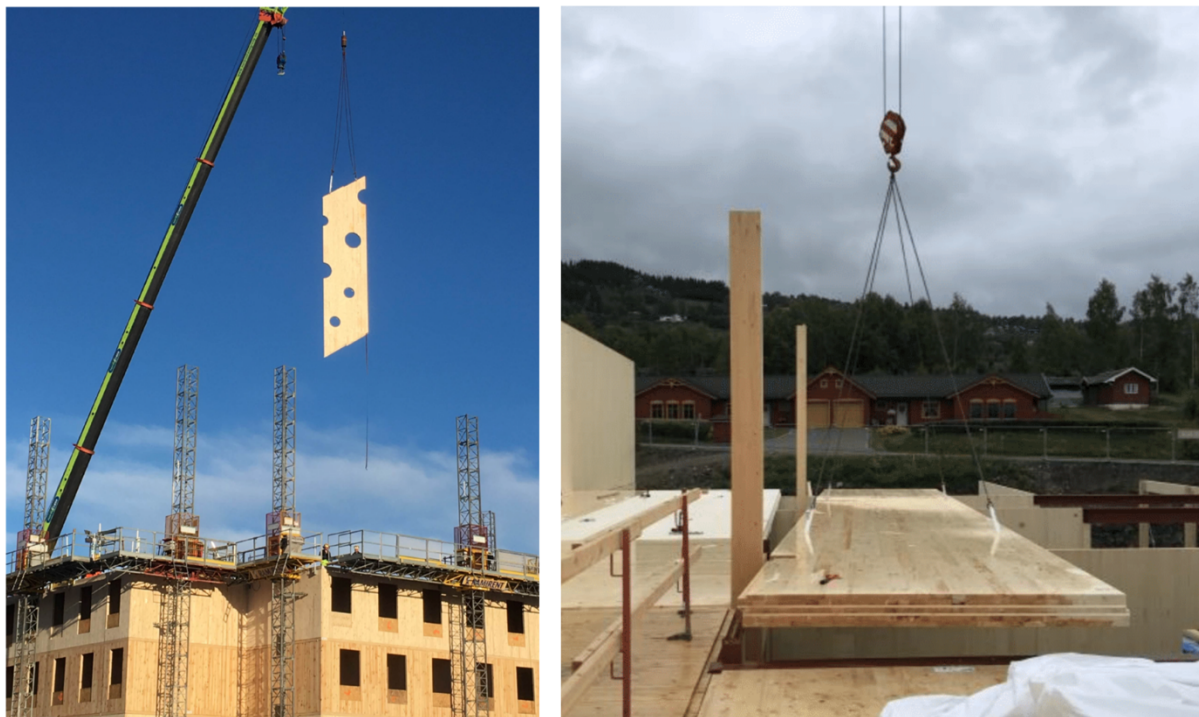
Figur 5 – Til venstre; montasje av veggelement i trappesjakt på Moholt 50|50. Til høyre; montasje av dekkeelement på Nordre Ål skole. Kilde: Veidekke Entreprenør
