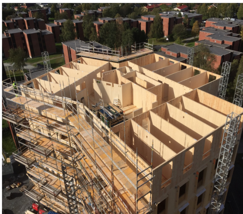
Moholt 50150. Kilde: Veidekke Entreprenør
