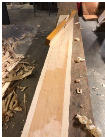
Figur 24. Høvling med fletthøvel ned til ferdig dimensjon.
