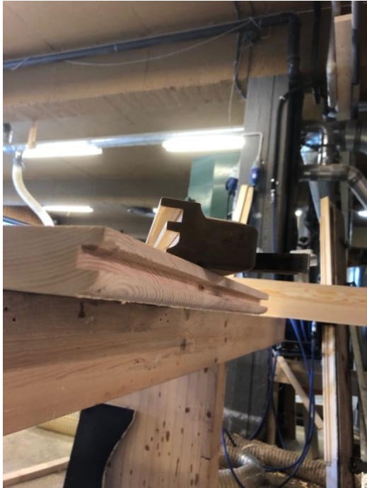
Figur 29. Høvling av endaved på fylling.
