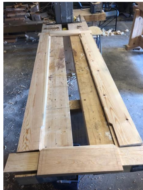
Figur 27. Dør ferdig tappet.
