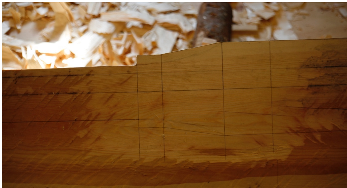
Bilde 33: Siden av basen mot portalåpningen hogget og slettet ferdig. Fotografi: forfatter
