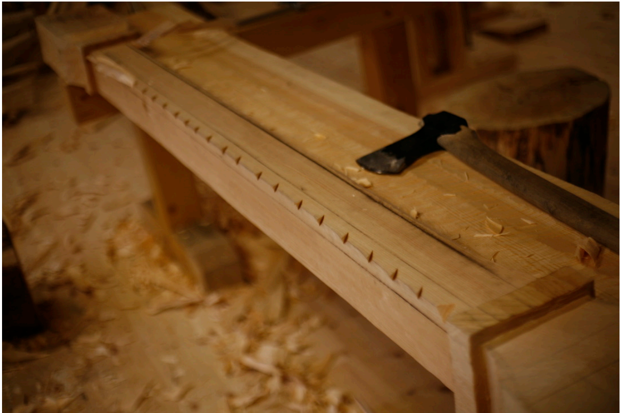
Bilde 57: Skvelling av fasene på søyleskaftet. Fotograf: forfatter
