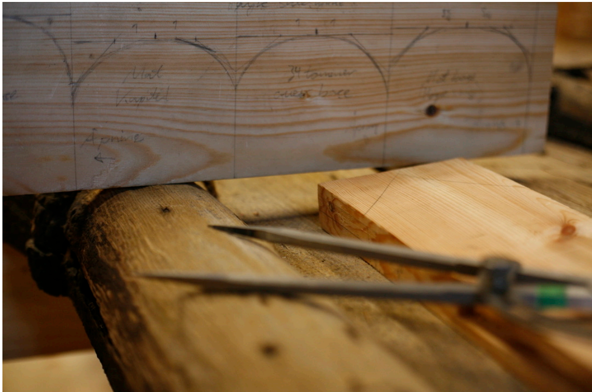
Bilde 55: Overføring av søyleskaftenes tverrsnit til en planke med stikkpasser. Fotograf: forfatter
