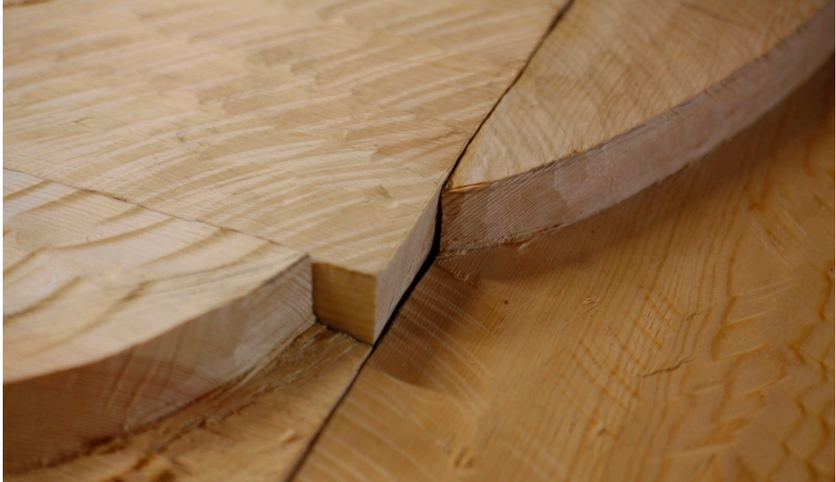
Bilde 98: Glippe som vil bli mer markant etter endelig forming av arkivolten. Skyldes at det ikke ble hogd godt nok i plan. Fotograf: forfatter
