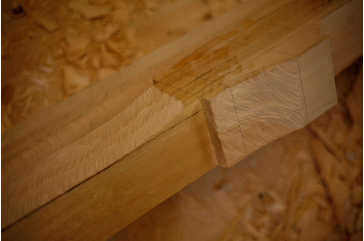
Bilde 49: På siden fibrene kom opp og ut av halsringen måtte det hogges rett kant etterpå. Fotograf: forfatter
