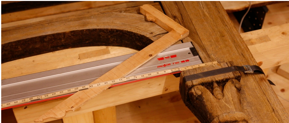
Bilde 9: Fysiske forsøk på å beregne radius til arkivolten ut i fra den bevarte ekstrados på arkivoltnakken på høyre vangetile. Fotograf: forfatter
