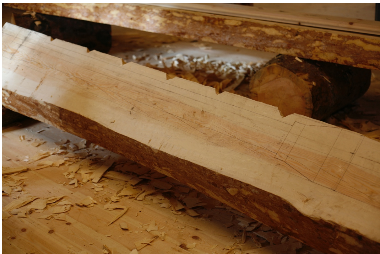
Bilde 32: Lomping av søylens side mot portalåpningen. Fotografi: forfatter
