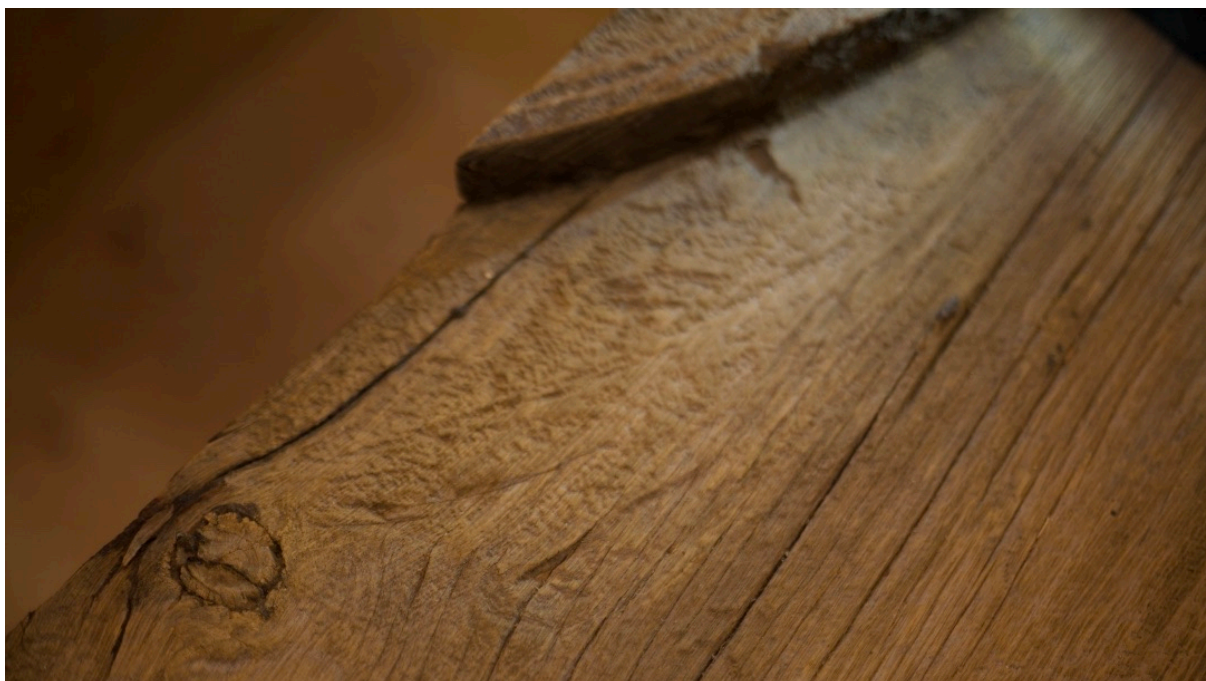
Bilde 11: Mest sannsynlig øksepor på siden av arkivoltnakken på venstre vangetile som kan stamme fra en større bue. Enten en større arkivolt, eller et forstadium til formingen av arkivolten. Fotograf: forfatter
