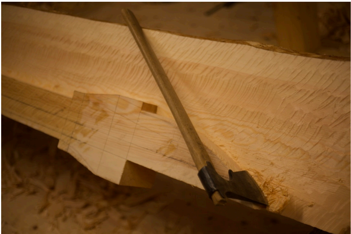
Bilde 42: Toppen av arkivoltnakken må det hogges rett in mot veggiledelen for å unngå utrifter. Spor som kan stamme fra dette steget var synlige på den originale, venstre vangetilen. Fotograf: forfatter
