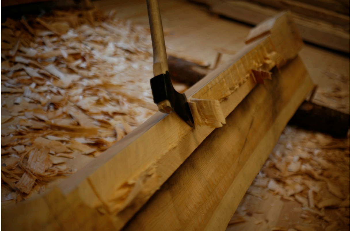
Bilde 47: Glepphogging av relieffet til søyleskaftet. Fotograf: forfatter
