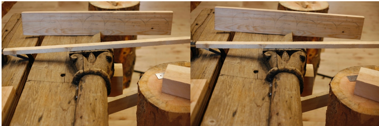
Bilde 6: To bilder, satt sammen, som forsøker å vise vridningen i søyleskaftet på den venstre vangetilen, mot den bakenforliggende veggtilledelen. Det blir samtidig tydelig hvor ulikt søyleskaftet fremstår om perspektivet vinkles etter veggtilledelen, eller abakusblokken. Fotograf: forfatter
