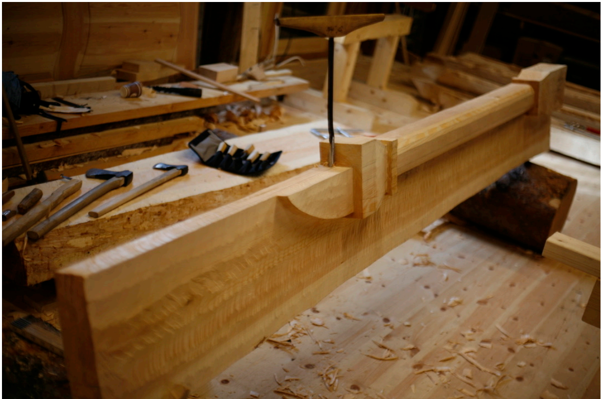
Bilde 62: Boring med navar av avslutningen til grøysporet mot abakusblokken. Fotograf: forfatter
