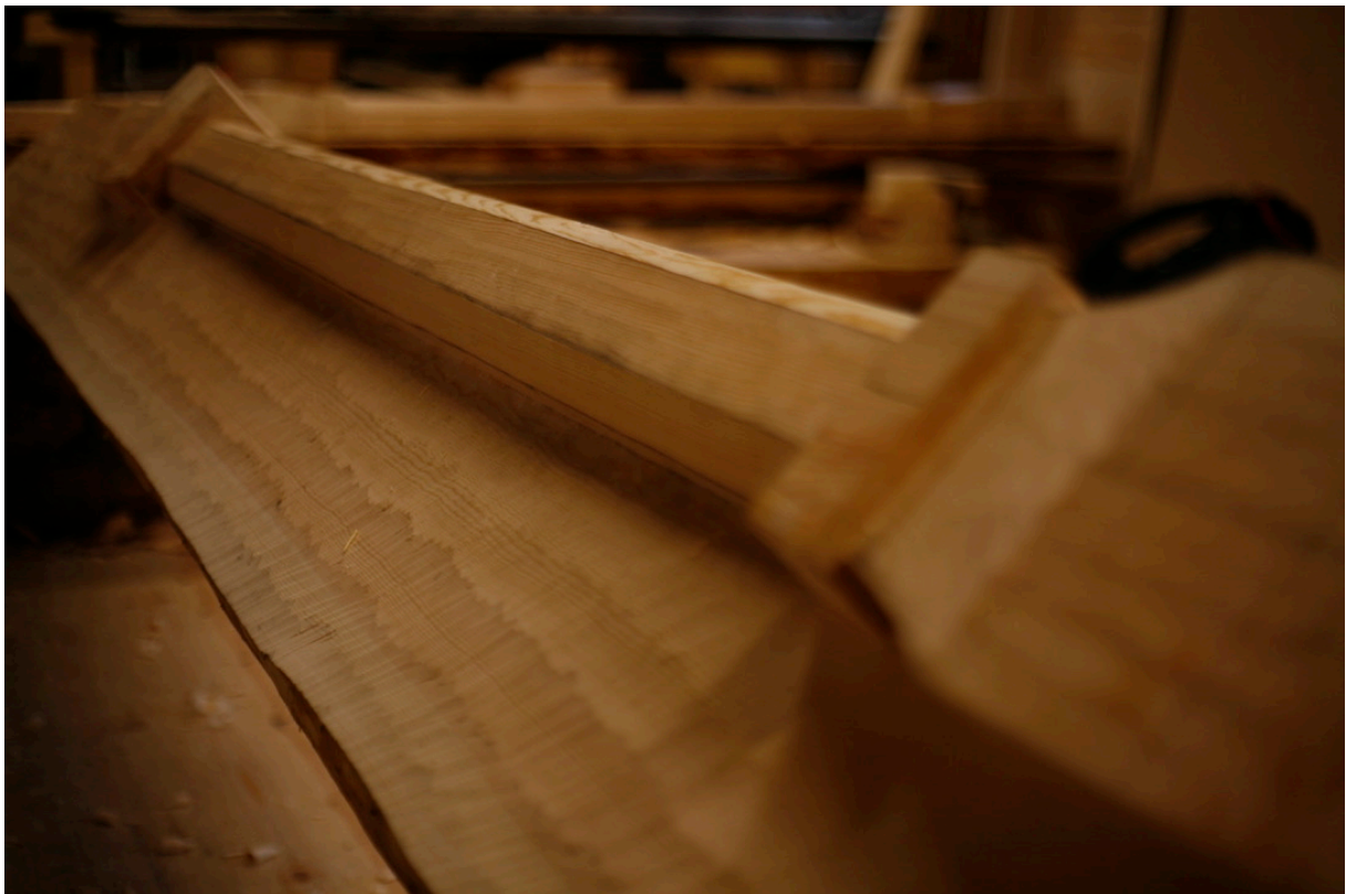
Bilde 59: Sletting av fasene på søyleskaftet. Fotograf: forfatter
