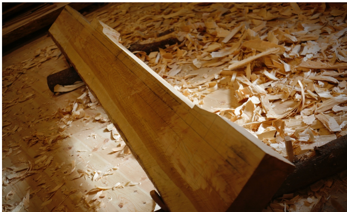
Bilde 34: Kanten av søylen mot portalåpningen og flaten mot overliggeren ferdig hogget og rettet. Fotografi: forfatter
