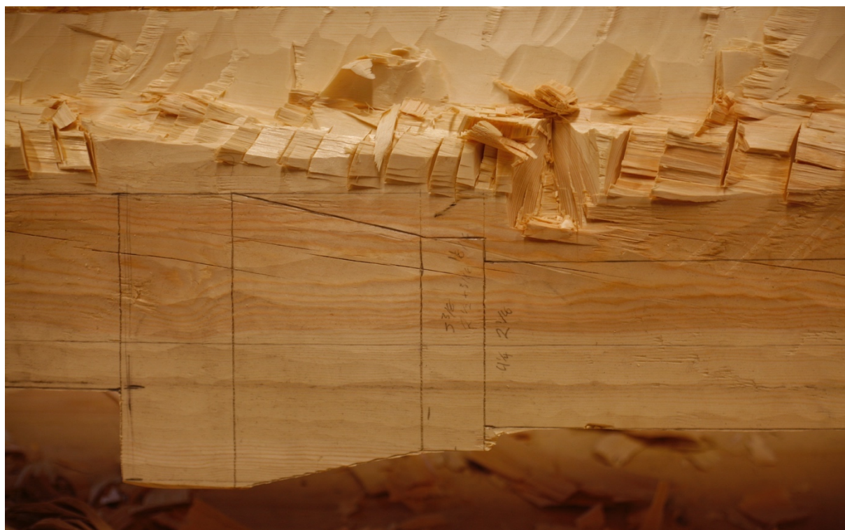
Bilde 38: Nærbilde av skvellet rundt kapitelet. Det er også spor etter en skåring som er fortsatt ned for å tillate hogging nært søyleskaftet. Fotografi: forfatter
