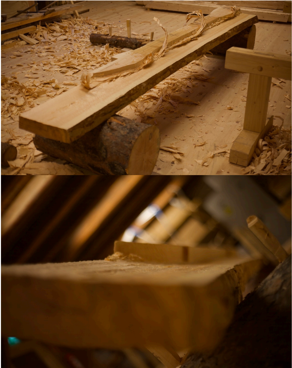
Bilde 40: Over: Spon fra hogging langsmed fiberretningen. Under: planet til veggiledelen inn mot søylen. Fotograf: forfatter
