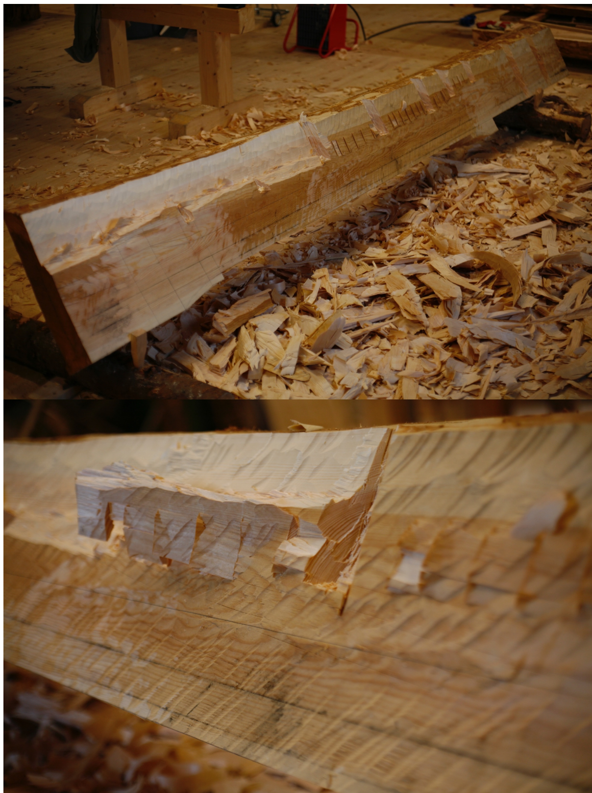
Bilde 36: Øverst: lompingen går gradvis over til å hogge langsmed fiberretningen. Fotografi: forfatter. Nederst: det er skvellet lett med hoggarøksa inn mot søylen slik at sponene slipper lettere og mer presist. Fotografi: forfatter
