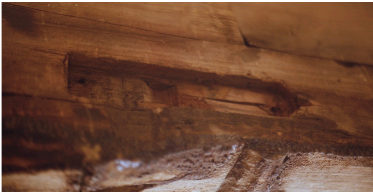
Bilde 12: Øvre hengselutsparring på venstre vangetile. Viser tydelige spor etter flatt tappjern og skruer. Fotograf: forfatter
