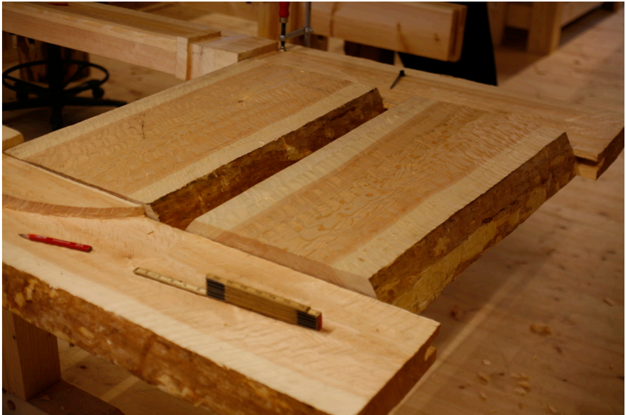
Bilde 85: Det øvre overstykket plassert mellom vangetilene. Fotograf: forfatter
