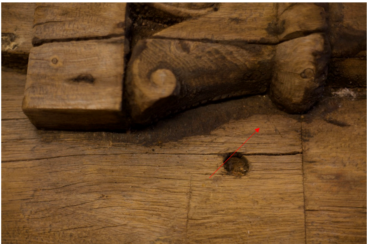
Bilde 7: Ikke-original side av venstre kapitel. Den bakenforliggende, originale veggtilledelen har linjer mellom abakusblokk og halsring som kan være fra formingen av et forstadie til kapitelet og halsringen. Fotograf: forfatter
