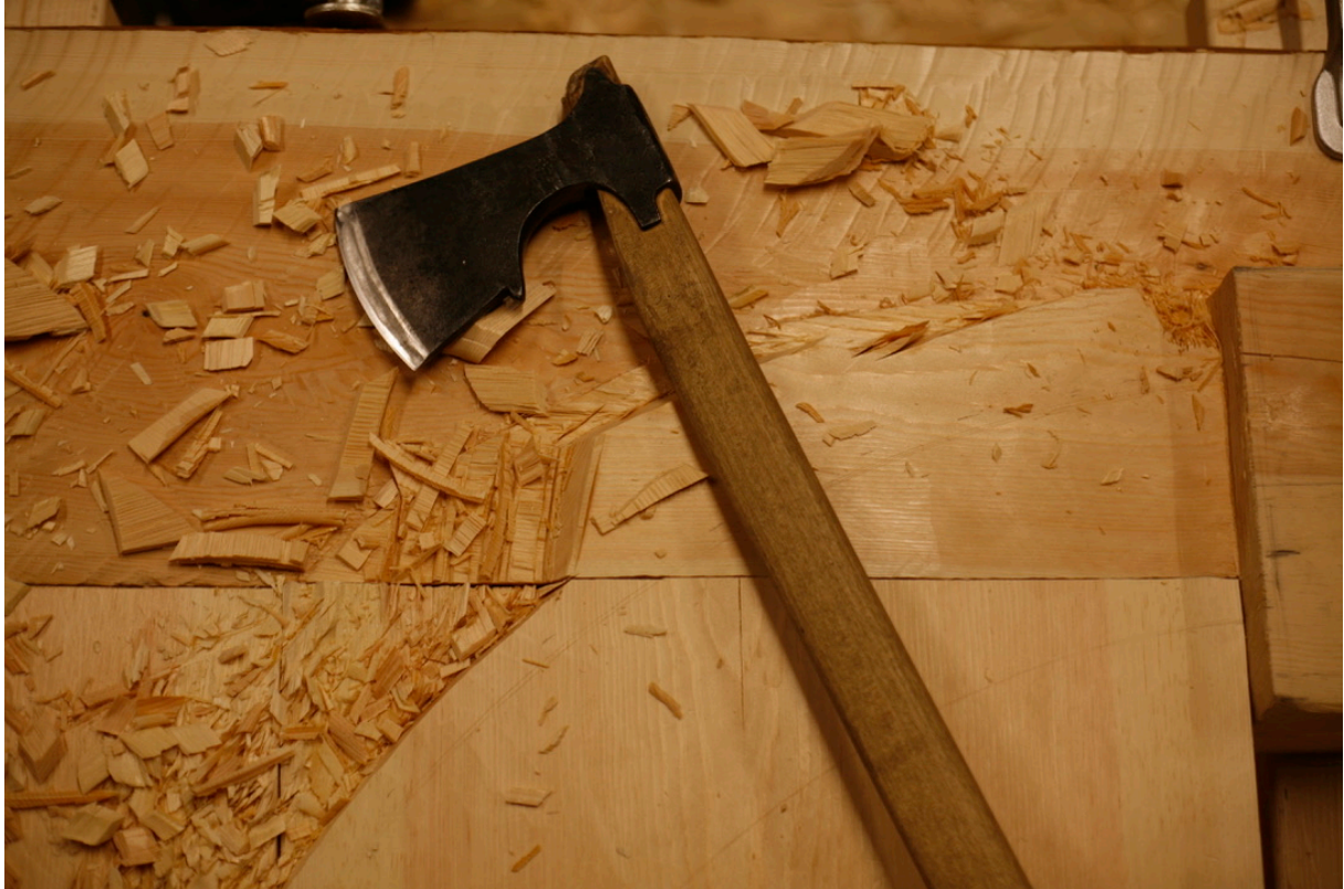
Bilde 107: Hogging av arkivoltnakken ned mot veggiledelen for å unngå utrifter der hvor det ikke var støtte i veden på overliggeren. Og hogging av kanten til kapitelet. Fotograf: forfatter
