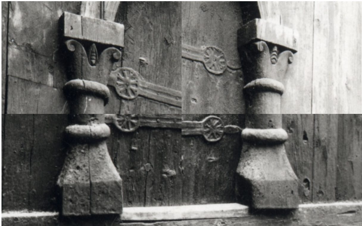
Bilde 8: Fire utsnitt av det tidligere viste bilde 5. Bildet forsøker å vise, i detalj, halsringene og hvordan de kobler sammen basene og kapitelene med søyleskaftet. Samtidig kan skyggene være missvisende for tolkninger av halsringens form, og det er derfor vanskelig å si om de er anderledes på bildet enn de er i dag. Fotograf: Anders Bugge.
