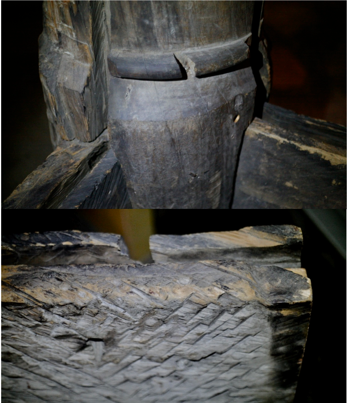
Bilde 19: Øverst: innsiden av staven på Suhmhuset, og dens møte med syllstokkene. På innsiden er det bevart en halsring, men den er rippet bort på utsiden. Fotograf: forfatter. Nederst: utsiden av venstre syllstokk med avtrykk etter en veggtile, og muligens et avtrykk etter basen til en inngangsportal. Kanskje den som har tilhørt døren som står i Haltdalen stavkirke. Fotograf: forfatter
