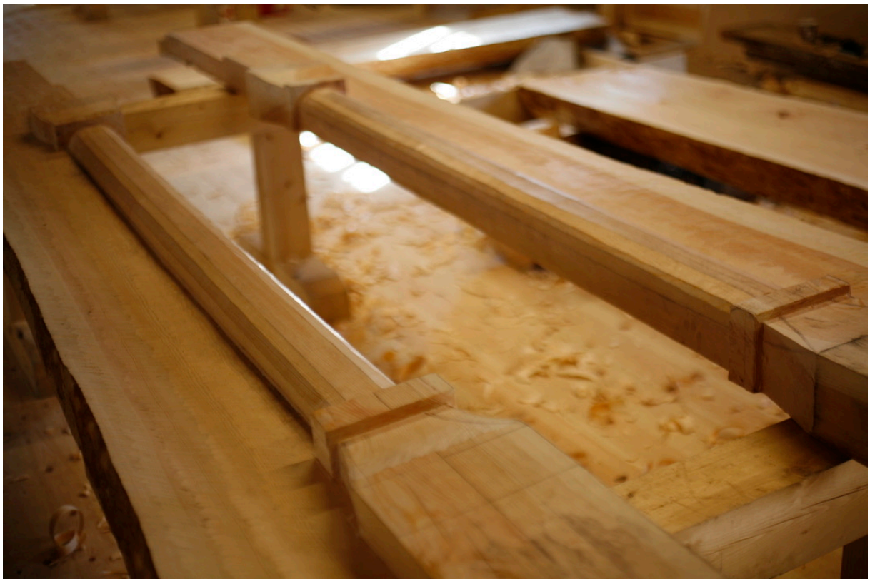
Bilde 60: De to vangetilene med søyleskaftenes faser ferdige. Fotograf: forfatter
