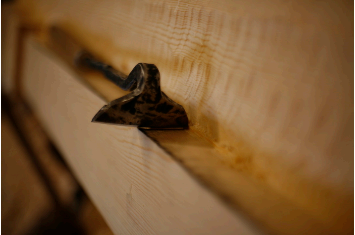
Bilde 43: Sletting av kanten på søyleskaftet med såtjern. Fotograf: forfatter
