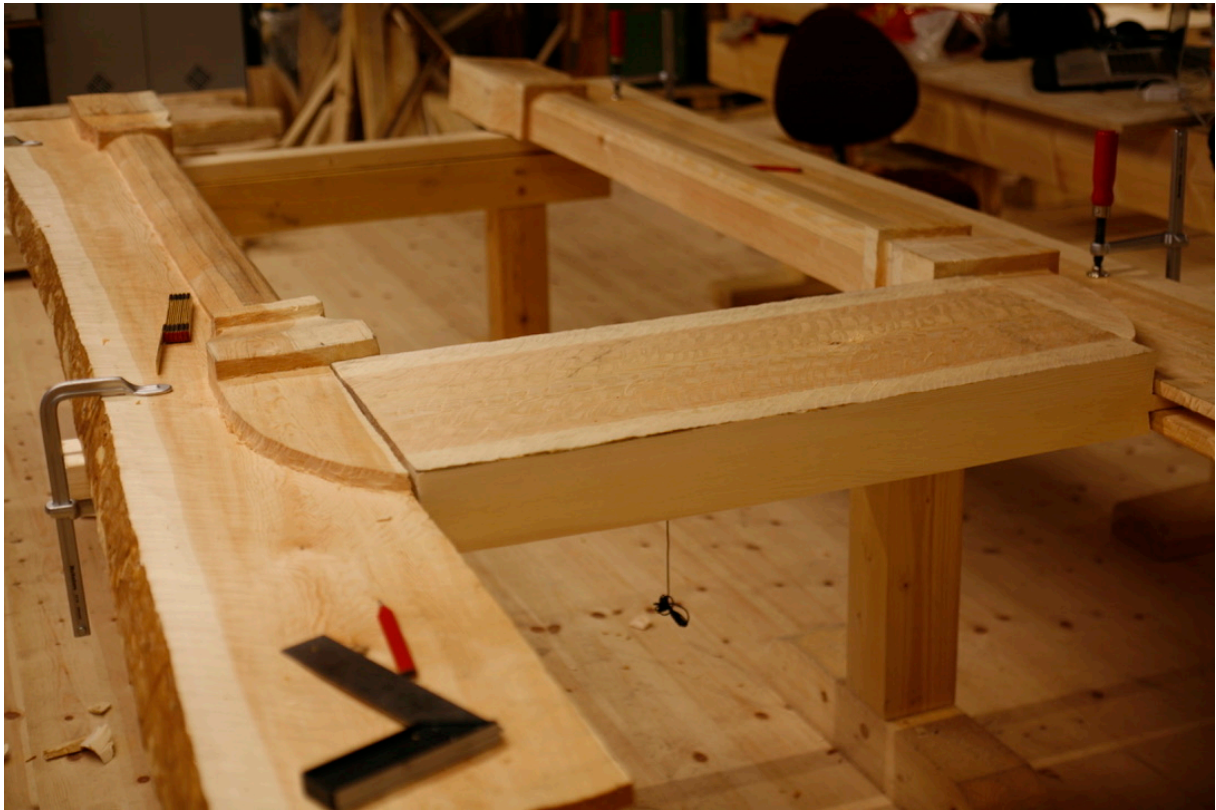
Bilde 86: Overkant av nedre overstykke kantet og slettet. Fotograf: forfatter
