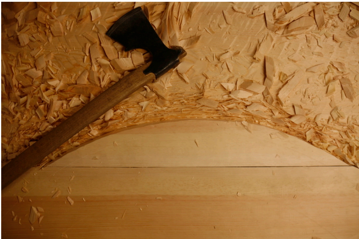
Bilde 104: Nærbilde som viser gradvis hogging av ekstrados til arkivolten på øvre overstykke. Fotograf: forfatter
