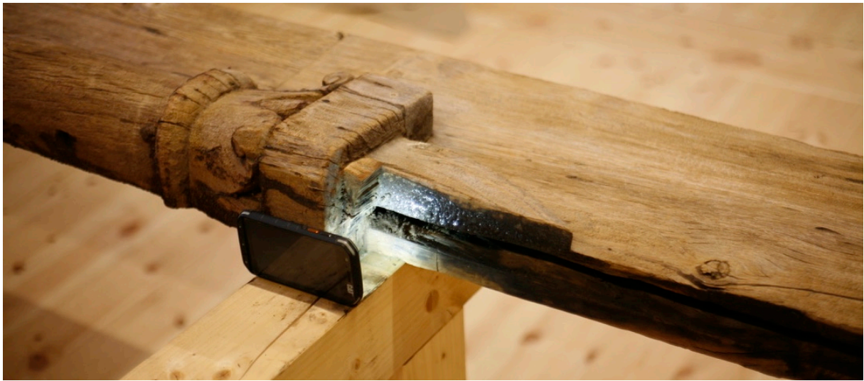
Bilde 14: Undersøkelser av bunnen av grøypsporet rett over abakusblokken på venstre vangetile. Fotograf: forfatter
