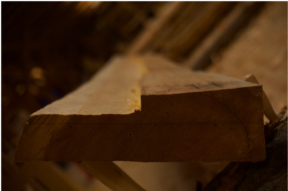
Bilde 39: Tverrsnitt av venstre vangetile. Fotografi: forfatter
