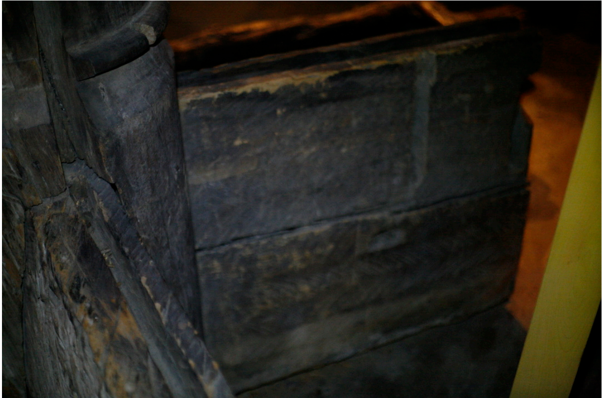
Bilde 20: Bilde av innsiden til staven og syllene på Suhmhuset i Trondheim. Nede på syllen i midten av bilde er det et tydelig skille i farge og slitasje som kan være hvor gulvet en gang har ligget. Fotograf: forfatter
