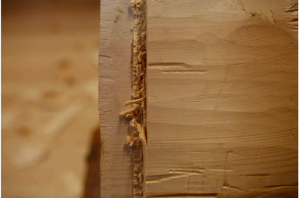
Bilde 92: Hogging av endeved etter meddragsriss. Fotograf: forfatter
