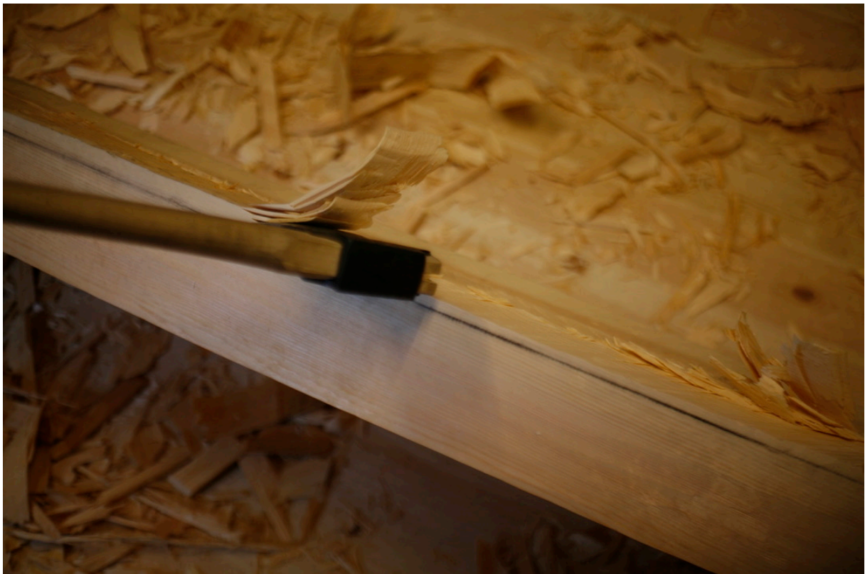
Bilde 48: Slik som sponen legger seg over øksa blir ofte kaldt styrespon. Det var viktig at øksa ikke glapp ut og hogde av denne nært halsringene. Fotograf: forfatter
