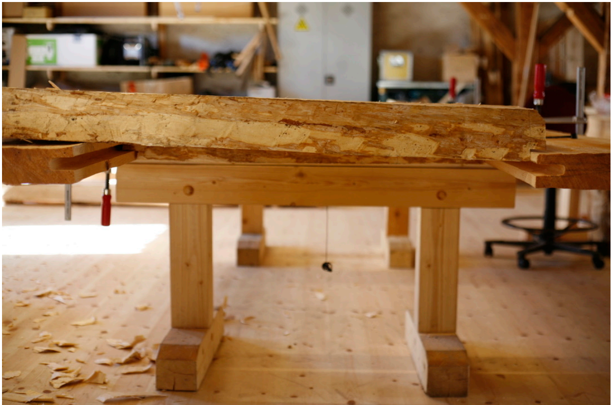
Bilde 78: Overstykket legges opp for å merke lengden. Fotograf: forfatter
