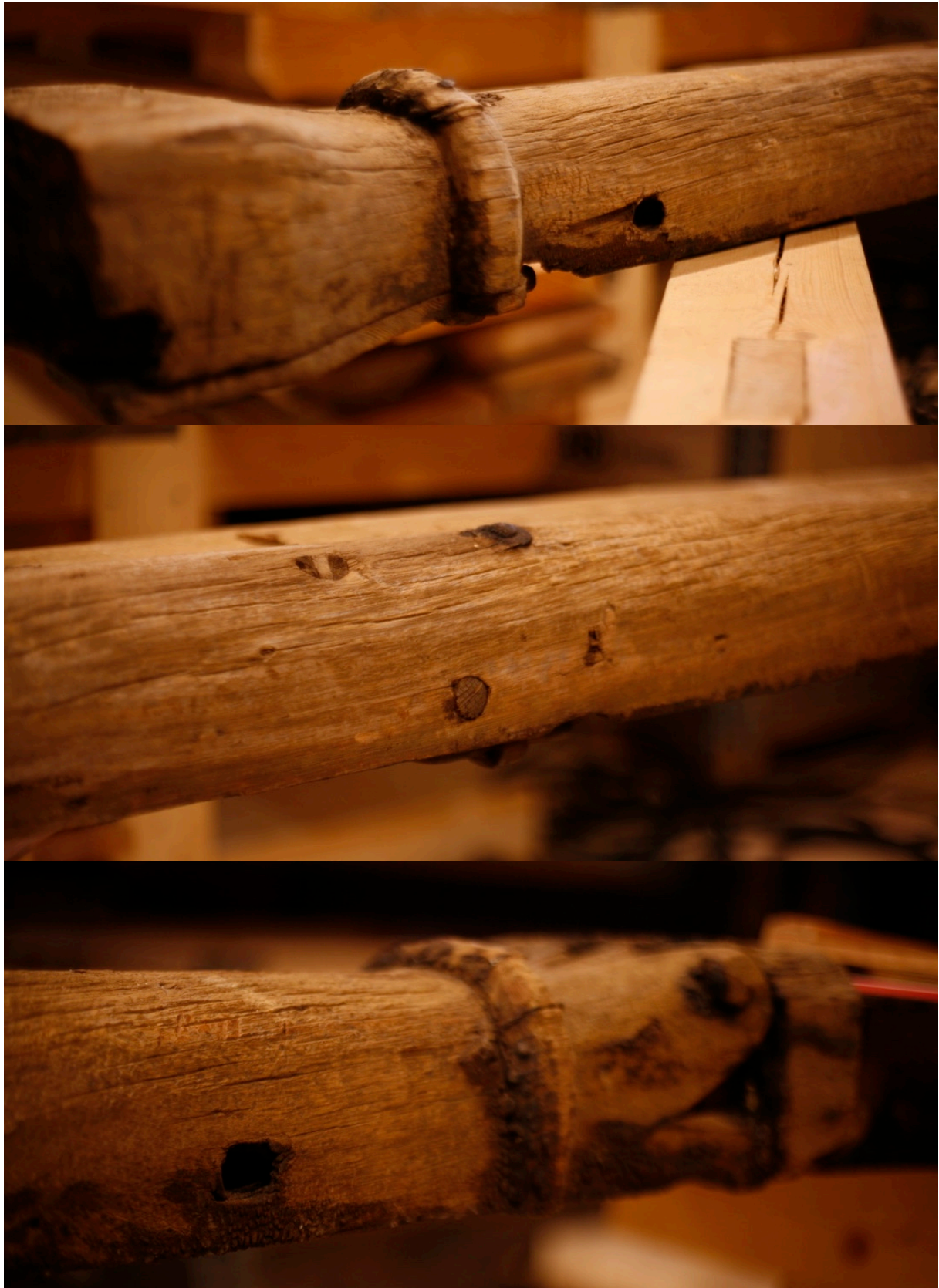
Bilde 13: Tre bilder som viser de tre koniske hullene etter navar på søyleskaftet, inn mot portalåpningen, på den venstre vangetilen. Fotograf: forfatter
