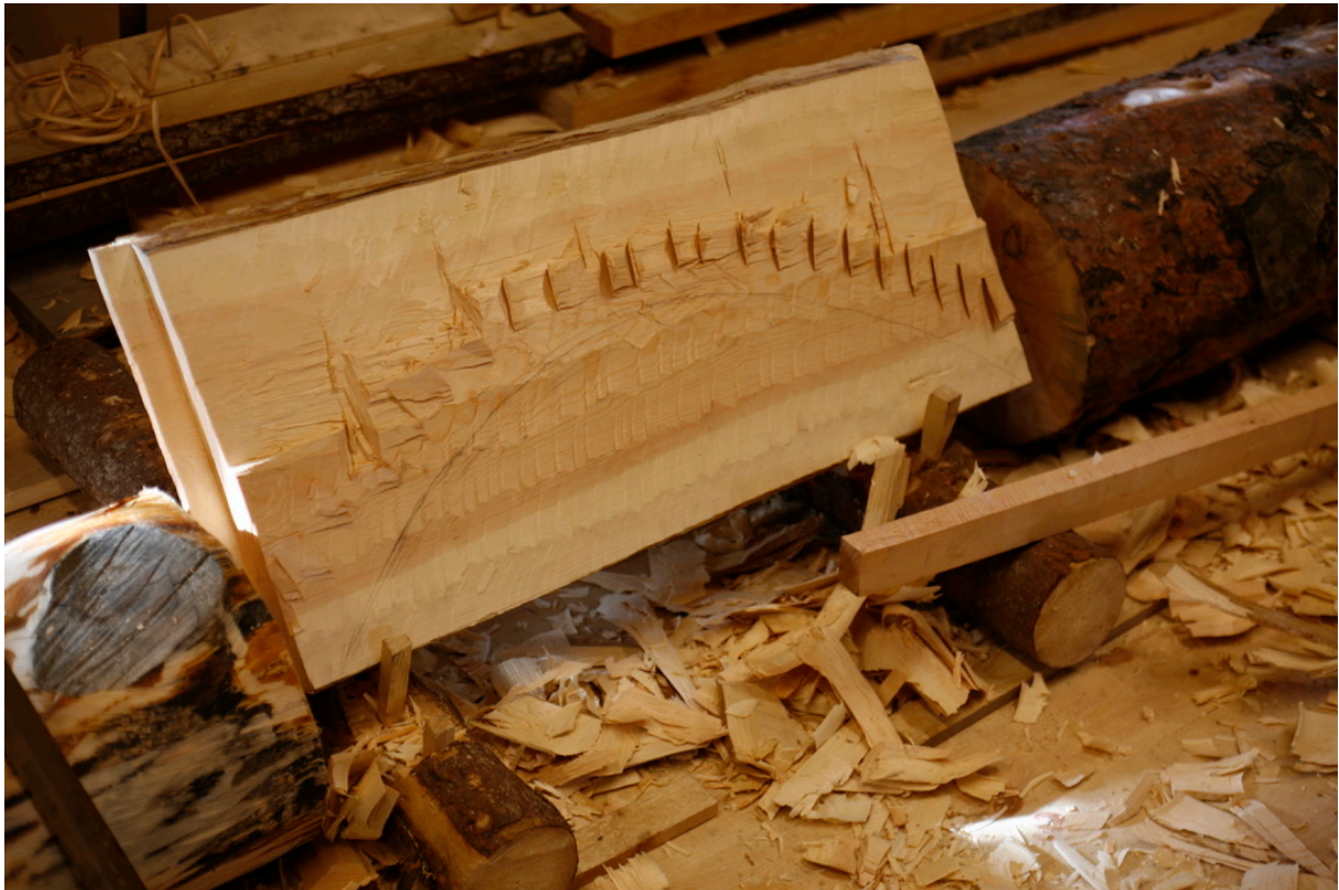
Bilde 89: Skvelling av kanten rundt arkivolten på det øvre overstykket. Fotograf: forfatter
