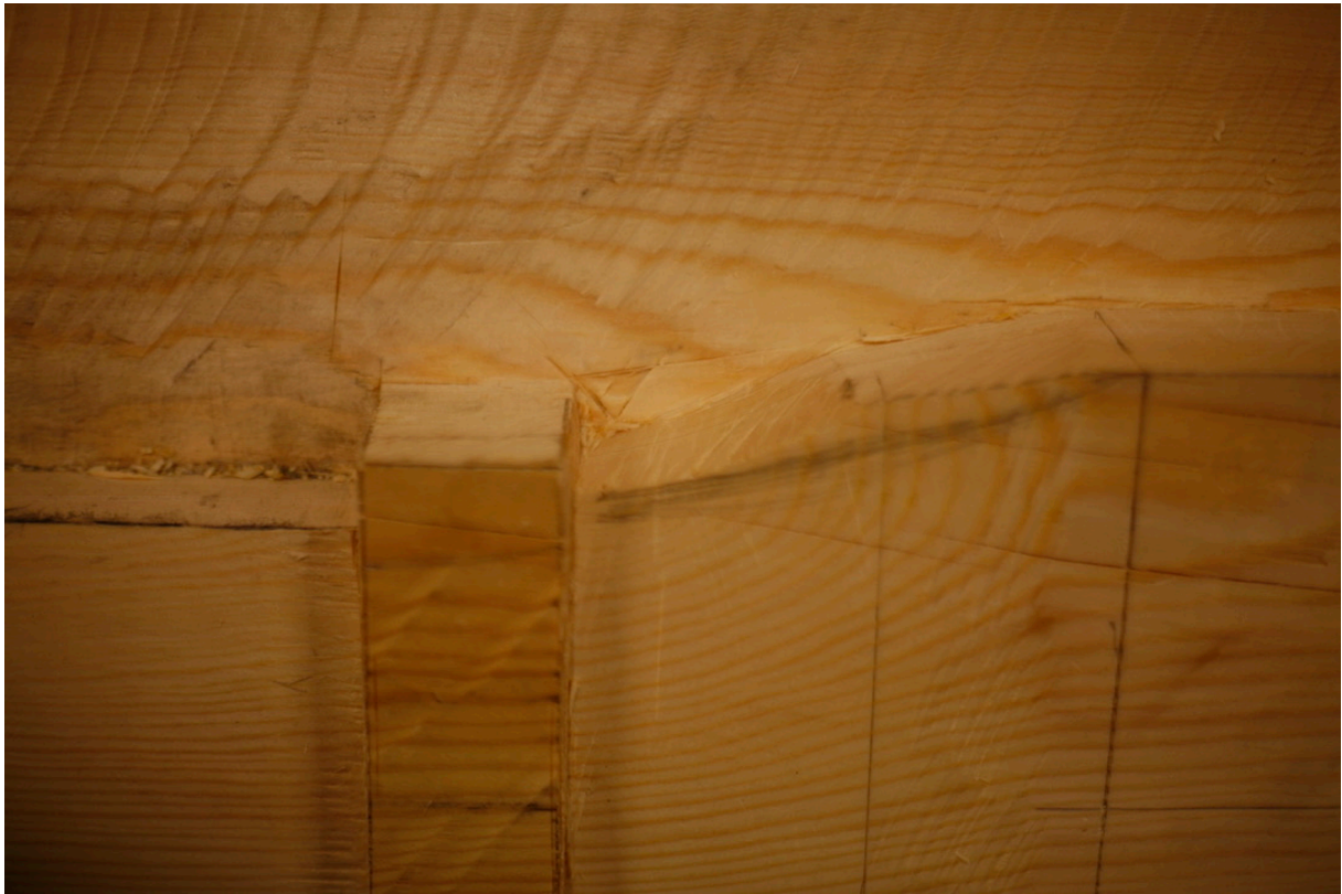
Bilde 53: Hogging av kanten på kapitelet. Det kan ha vært tilsvarende spor som de over halsringen på den venstre vangetilen. Fotograf: forfatter
