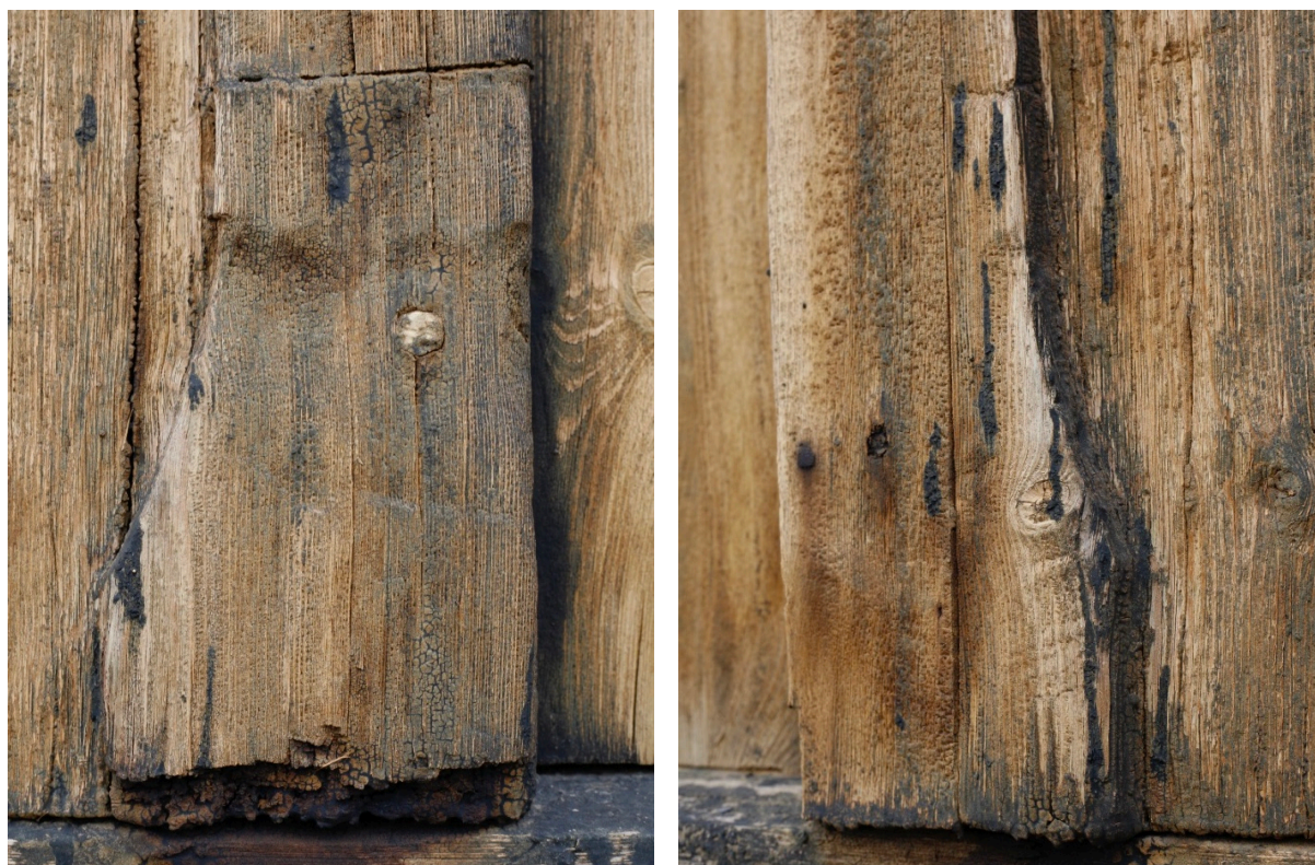
Bilde 17: Venstre: basene på venstre vangetile, høyre: basene på høyre vangetile, til portalen på sørveggen av skipet til Haltdalen stavkirke. Fotograf: forfatter
