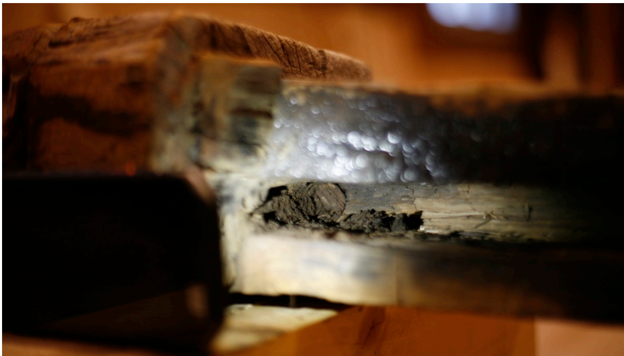
Bilde 15: Spor etter navar i bunnen av grøypsporet, rett over abakusblokken på venstre vangetile. Fotograf: forfatter
