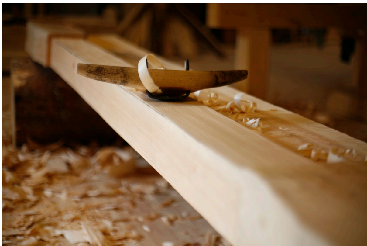
Bilde 52: Sletting med pjål av relieffet på søyleskaftet. Pjålen var det raskeste verktøyet, men vanskeligere å kontrollere nøyaktig og komme til med på de vanskeligste plassene. Fotograf: forfatter
