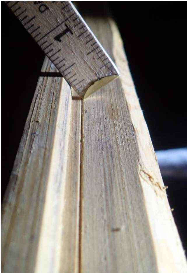
Bilde av fjør, med knekt kant og et v riss i kanten. Foto. Henning Jensen
