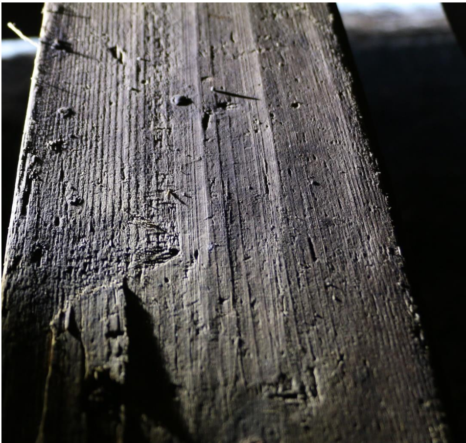
Spor etter buet høvelstål. Litt utriv ved kvist og motved. Foto: Henning Jensen
