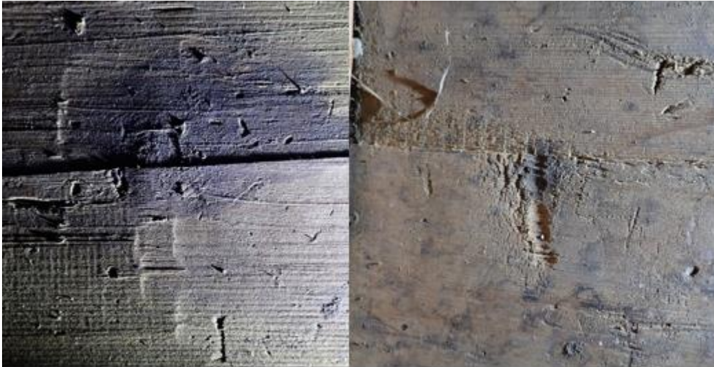
Trolig startmerker etter høvling, samt vibrasjonsspor. Utriv ved kvist og sagskur i hjørnet. Foto: Magnus Wammen
