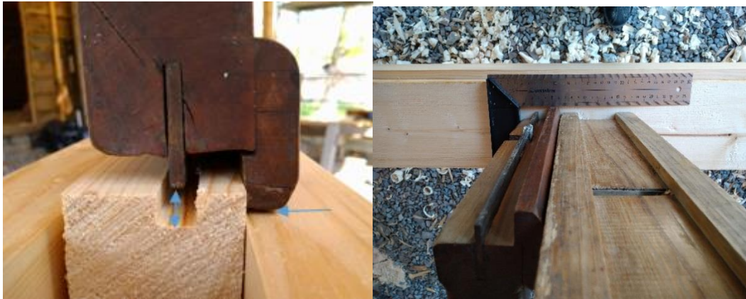
Anlegget på ploghøvlen stopper i langbordet, fordi det stikker lenger ned en meiene på føioksen. Planken må heves lenger over langbordene. Foto: Henning Jensen
