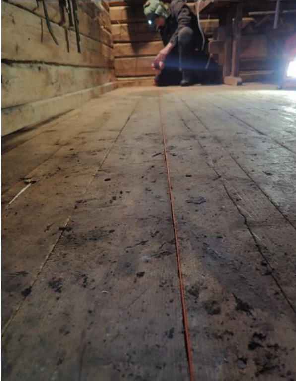
Dokumentasjon av originalgulvet. Foto: Henning Jensen
