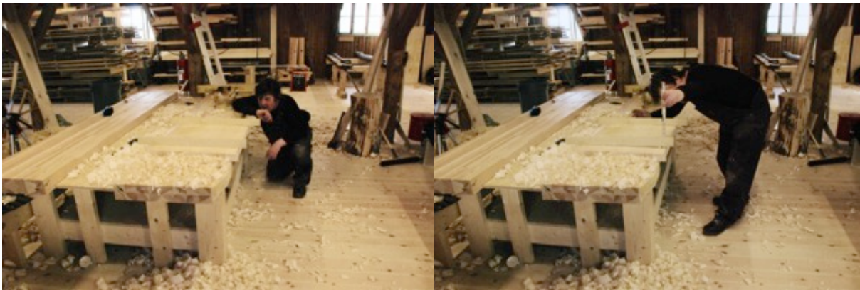
Figur 74 Sikting og nivilering. Foto: PWB
