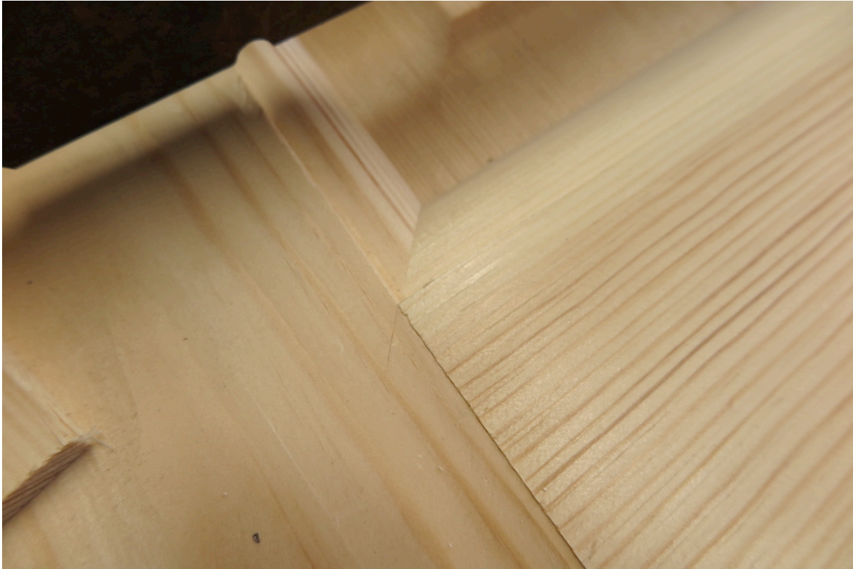
Figur 90. Detalj, ramtre og gjæring. Foto:HTF
