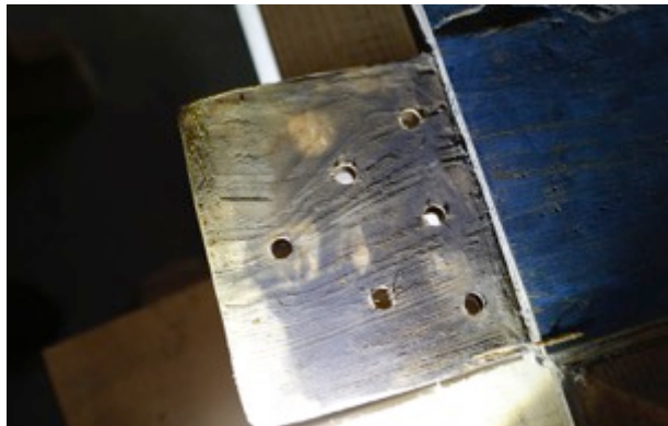
Figur 15 Tapp og høvelspor. Foto: RR
