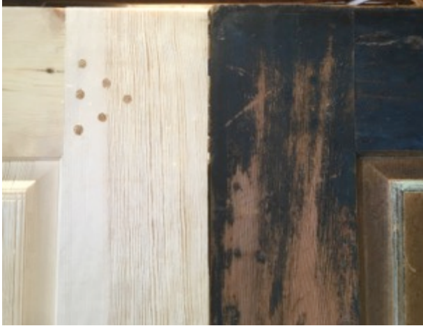
Figur 108. Naglar i ny og gammel dør. Foto: PWB
