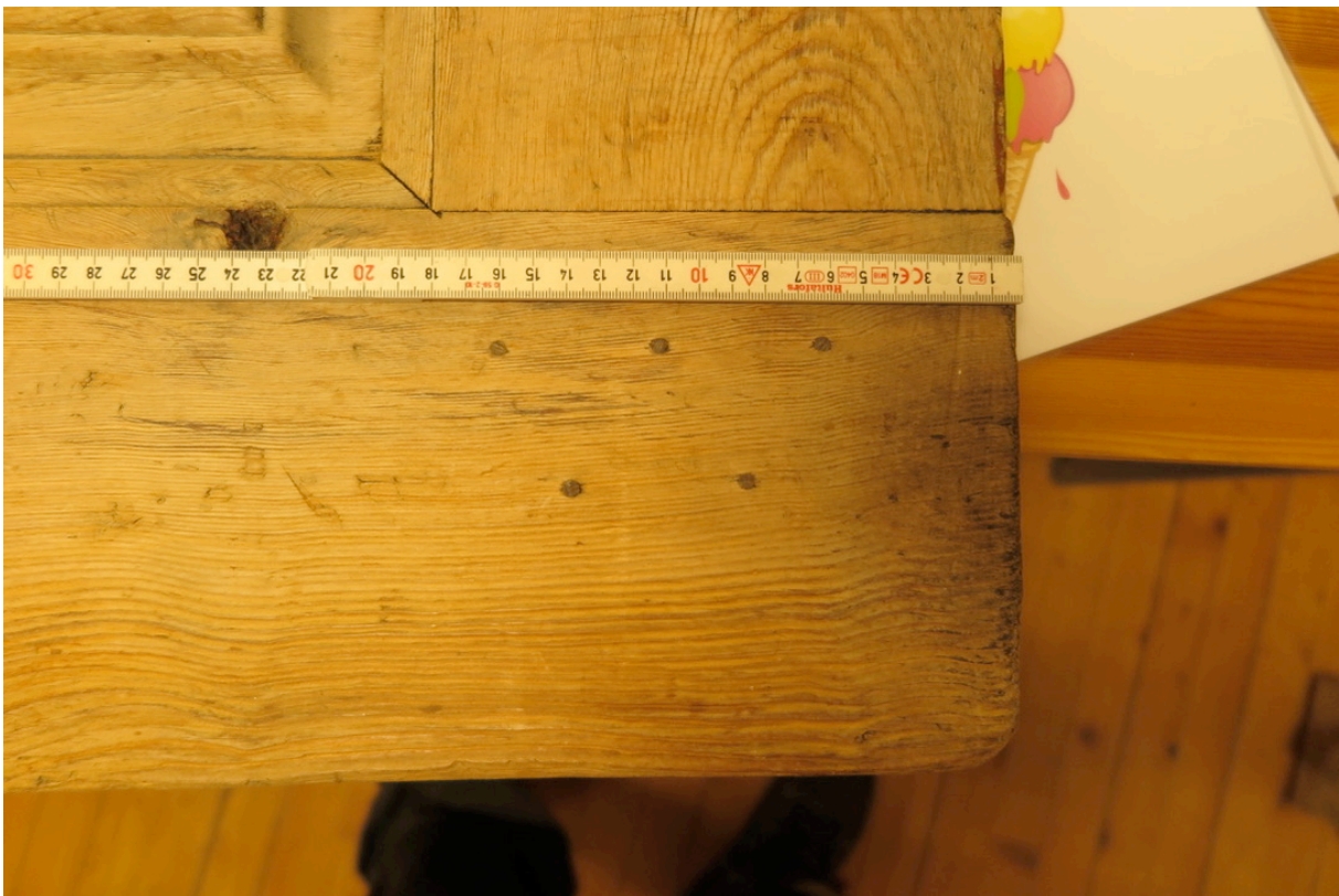
Figur 17. Nagleplassering. Foto:HTF
