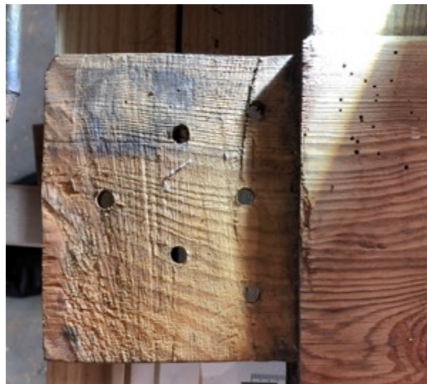
Figur 13 Tapp og verktøyspor. Foto: RR
