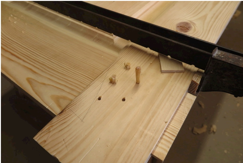
Figur 94. Nagling av ramtre. Foto:HTF
