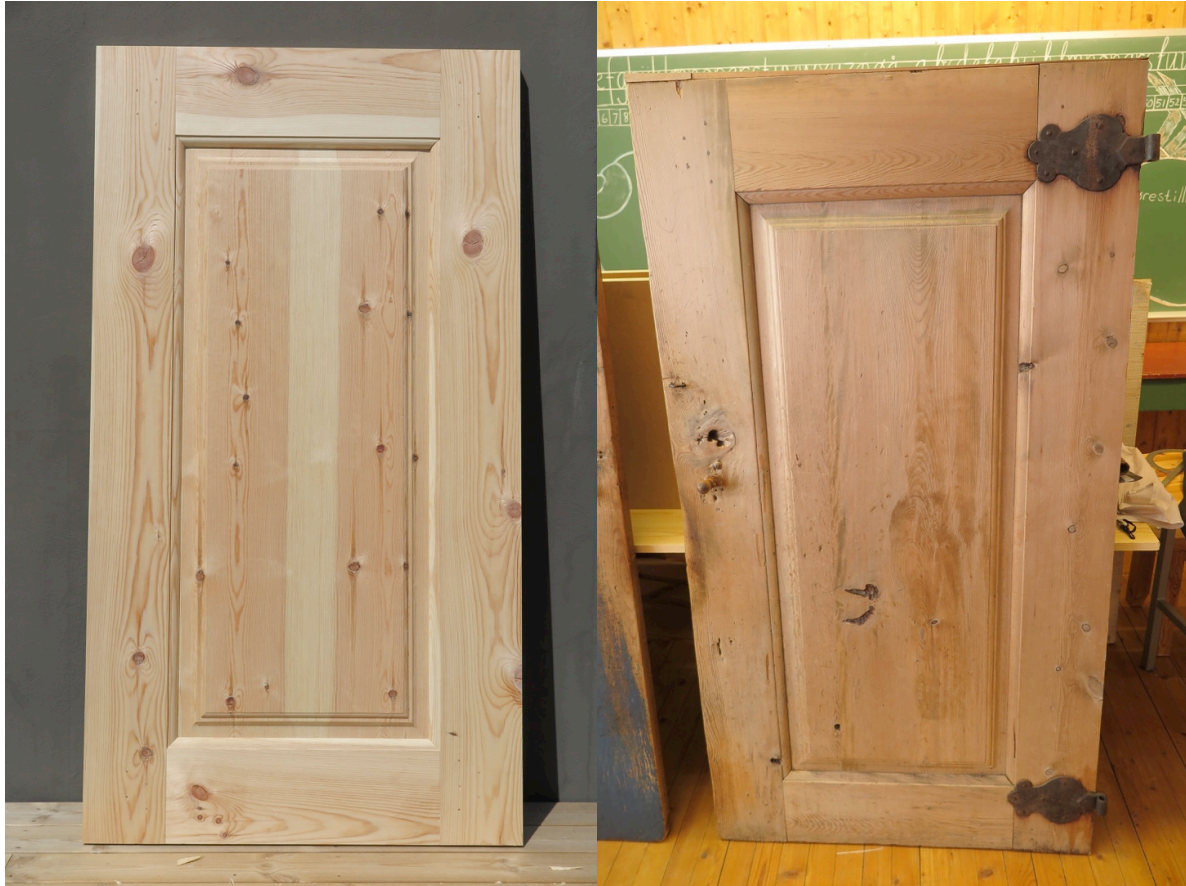
Figur 100. Ny og original dør. Foto: HTF
