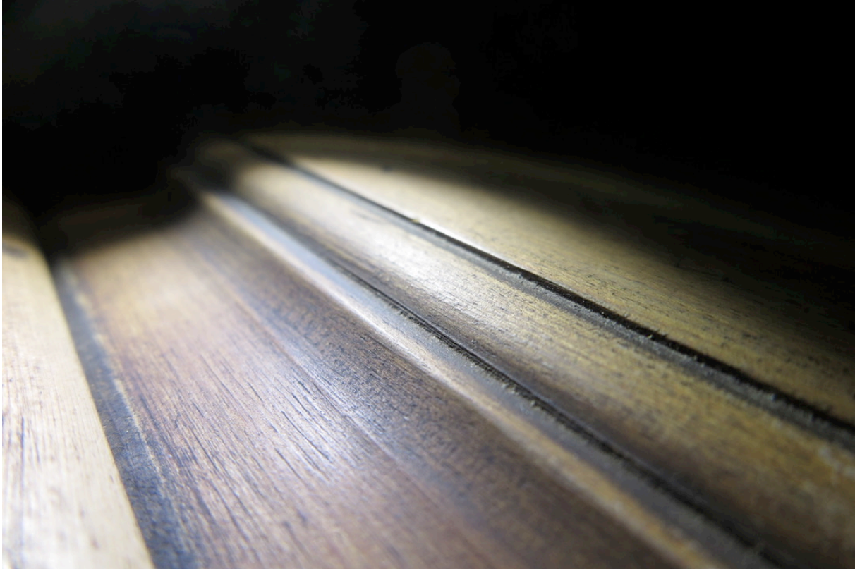
Figur 9. Fyllingsprofil. Foto: HTF
