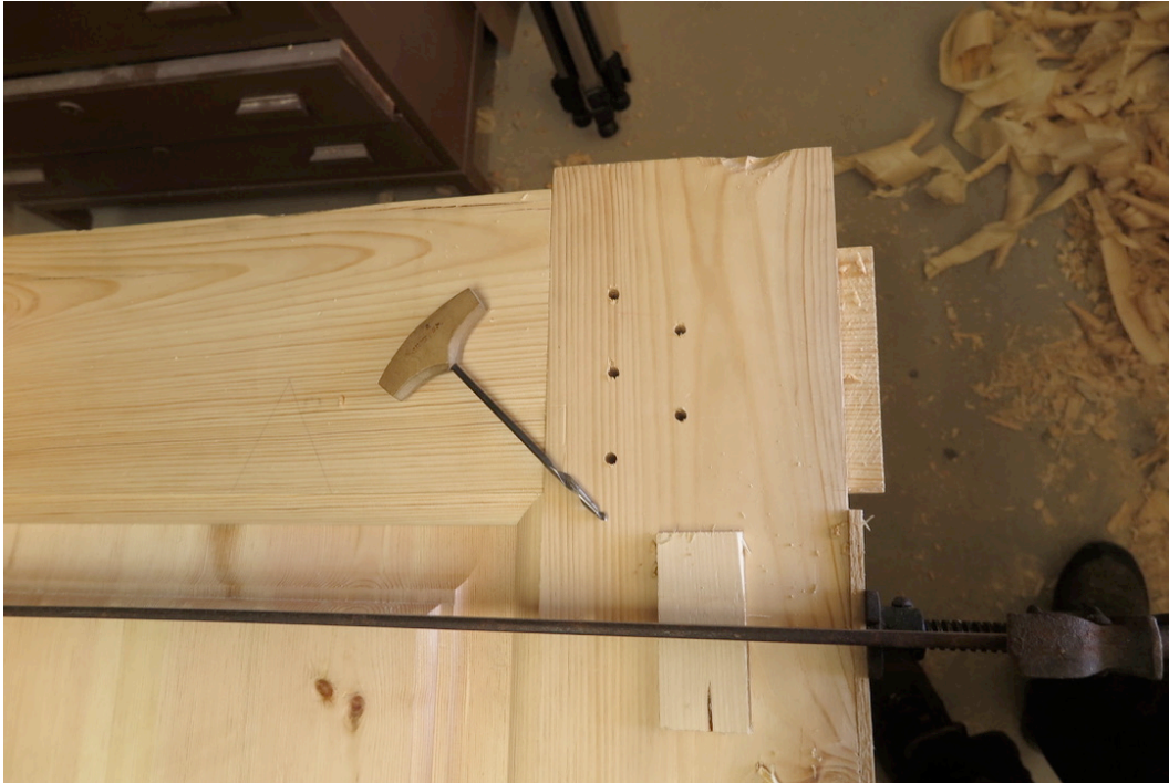
Figur 90. Boring av naglehol med navar. Foto:HTF
