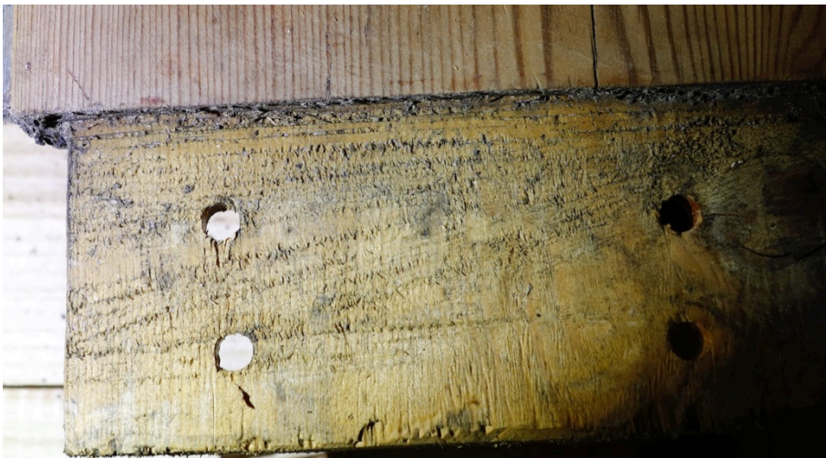
Figur 32. Sagsnitt etter kappsag i fleire omgangar?
