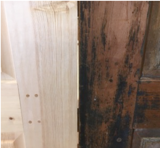
Figur 109 . Naglar i midtramtre. Foto: PWB
