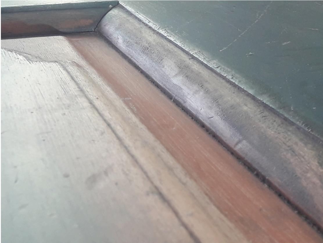
Figur 13. Kwartstaffprofil på ramtre. Foto: HTF
