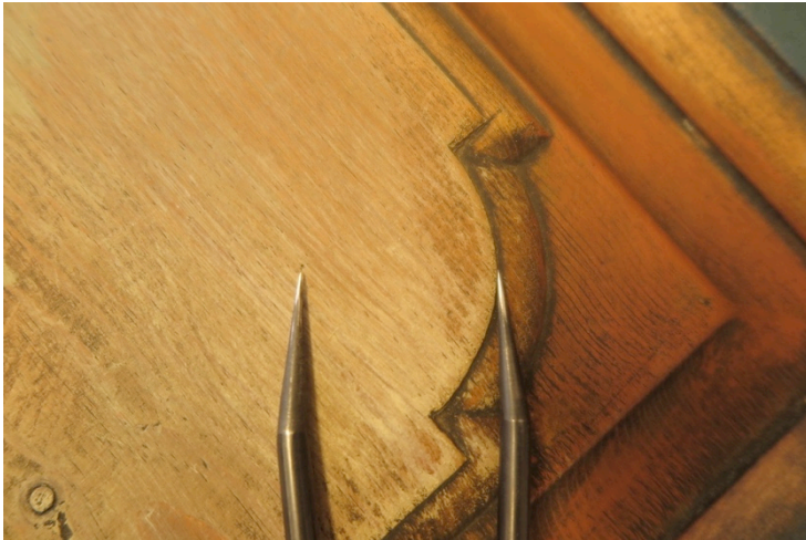
Figur 12. Dekor i hjørne av kvartstaffprofil, fylling. Foto: HTF
