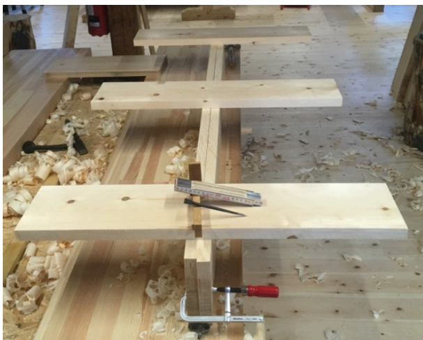
Figur 48 Plasering av tverramtre. Foto: PWB
