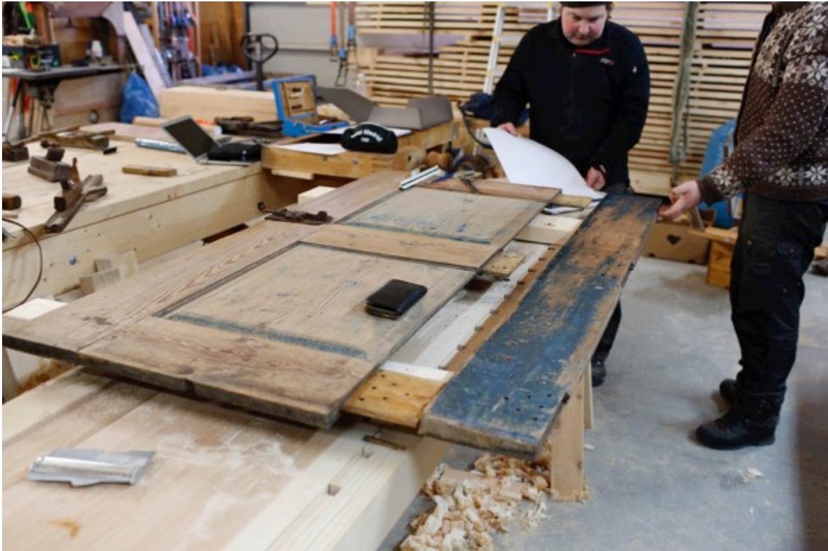
Figur 2 Demontering av langramtree. Foto: RR
