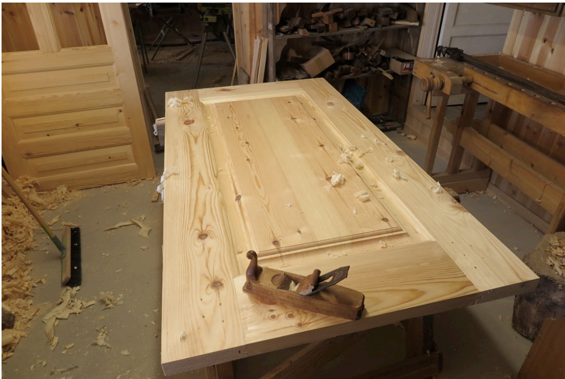
Figur 97. Pusshøvling av dør. Foto:HTF
