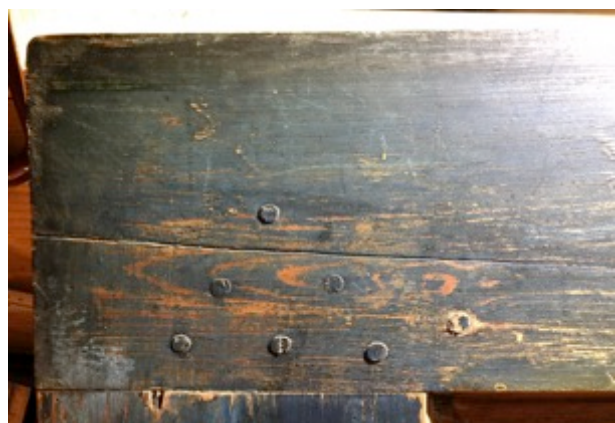
Figur 6 Riss etter plasering av tverramtre. Foto: RR
