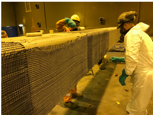
Figur 2: Påførsel med armering er eit krevjande arbeid
