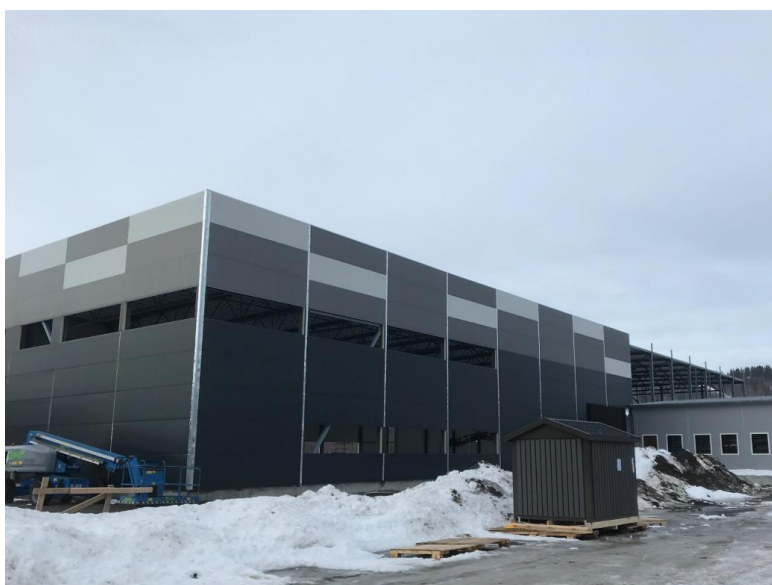
Figur 4: Bilde av de nye produksjonslokalene under utbygging. En ferdig nettstasjon i forgrunnen
