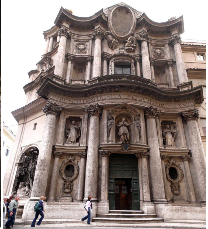
Figur 7. San Carlo fasade
