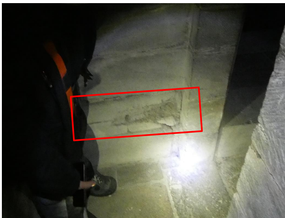
Bildet viser merker etter lange og brede dørhengsler i Mariakapellets søndre, nedre hjørnerom.
