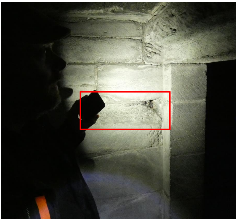
Bildet viser merker etter lange og brede dørhengsler i Mariakapellets søndre, nedre hjørnerom.
