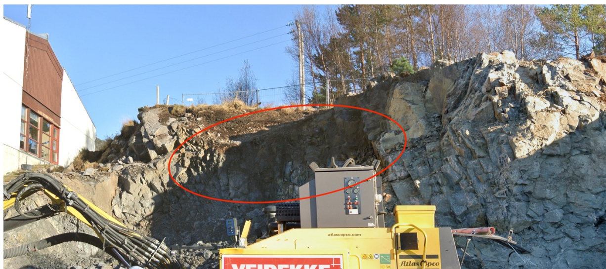
Bilde 6. Spesielt oppsprukket sone med nedsatt bergmassekvalitet. (Originalfoto: Norconsult, 29.10.18)
