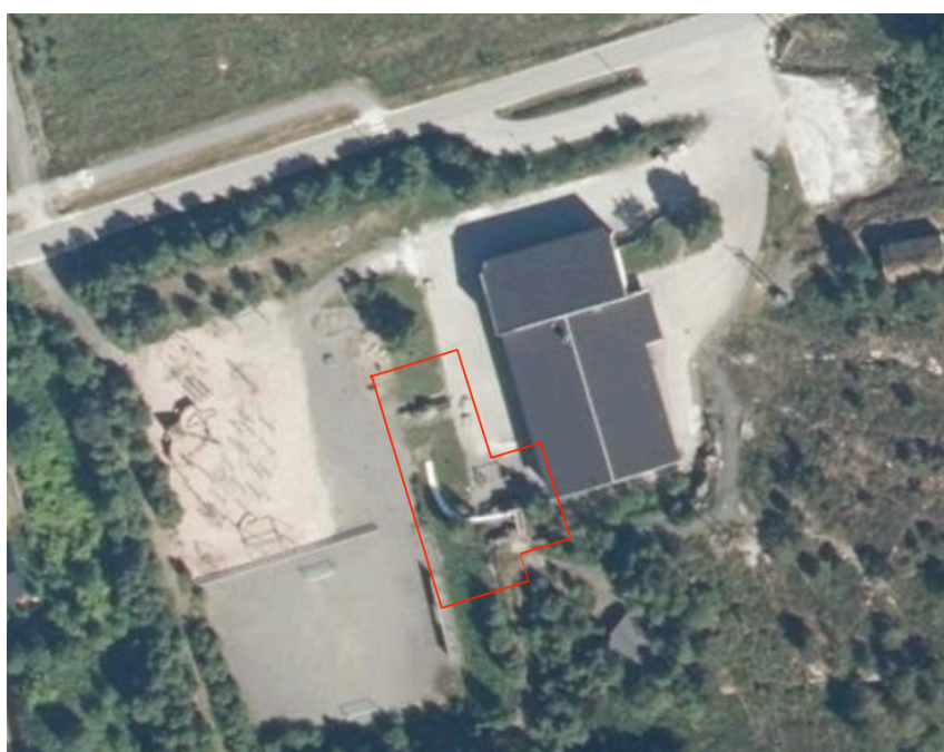
Figur 2. Oversiktsbilde av byggetomten, planlagt bebyggelses omtrentlig fotavtrykk markert med røde streker. (2)
