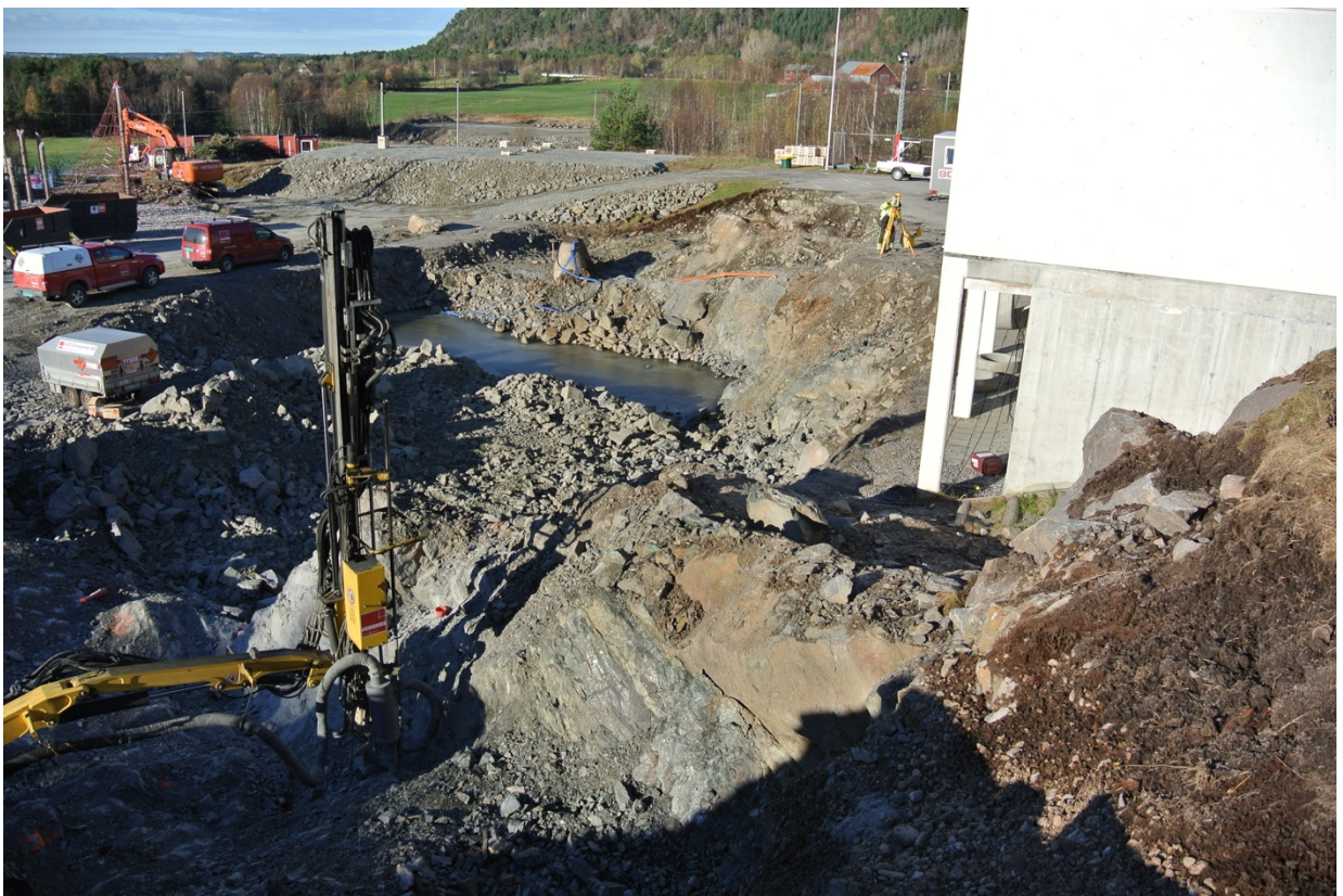
Bilde 5. Fotografi tatt mot nord-vest under ingeniørgeologs befaring. (Norconsult, 29.10.18)
