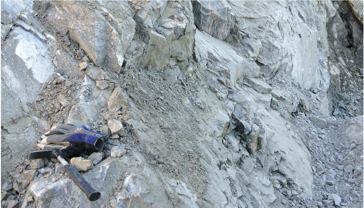
Bilde 1. Fotografi fra befaring med Norconsults ingeniørgeolog. (Norconsult, 29.10.18)
