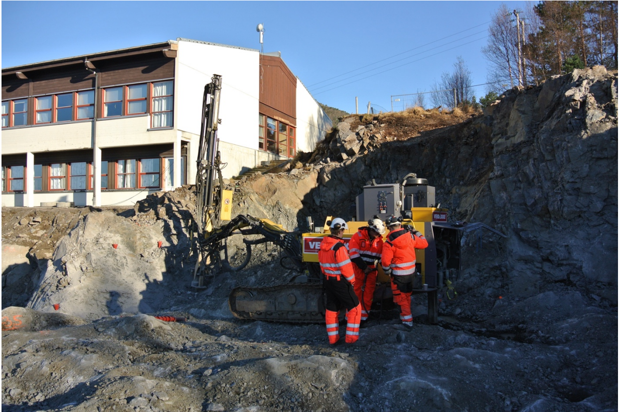
Bilde 4. Fotografi tatt mot nord-øst under ingeniørgeologs befaring. (Norconsult, 29.10.18)
