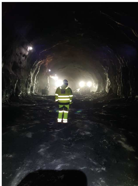
Andreas Skain overvårer arbeidene med bunnrensen i Soknedalstunnelen
