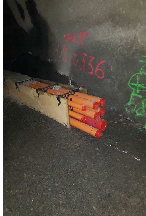
Figur 7: Plasstøpte kabelkanaler. (OPI-kanal)
