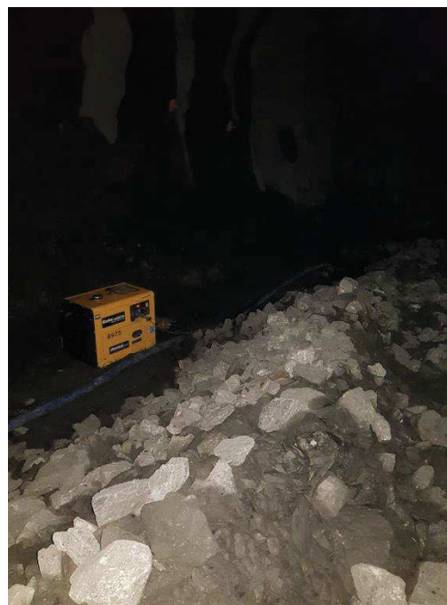
Figur 6: Grøftene pumpes tom for vann før fundament til drens etableres.
