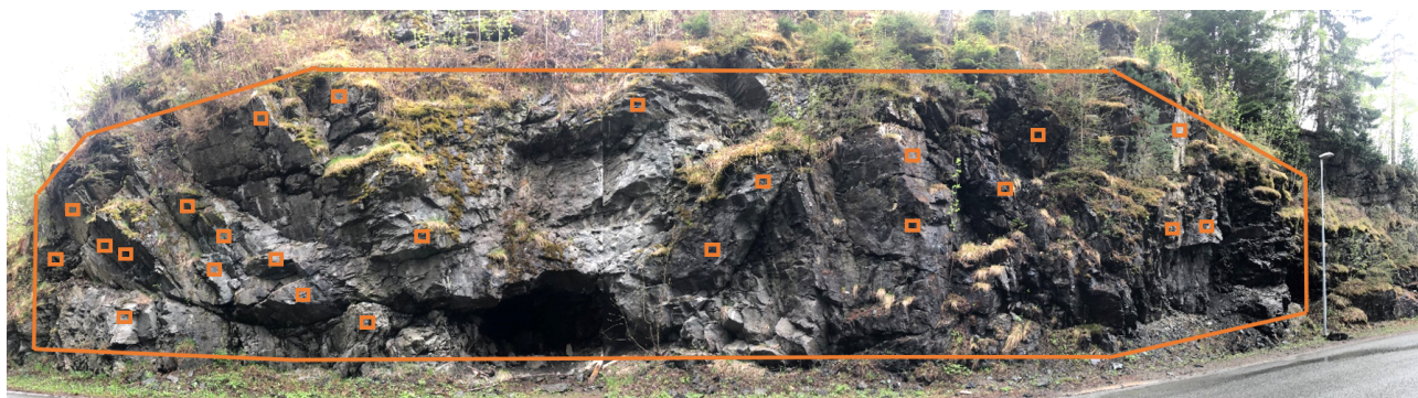
Figur 37: Forslag til sikringstiltak for hele skjæringen. (Foto: A. E. Hollen)
