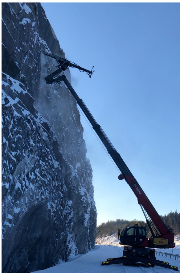
Figur 12: Bolting med teleskoptruck i fjellskjæring. (Foto: M. H. Hansen)
