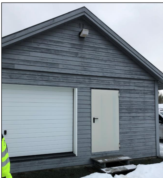
Figur 13: Foto – Inngangsparti, vannbehandlingsanlegg
