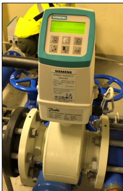
Figur 8: Foto – Vannmåler i vannbehandlingsanlegg på Eid
