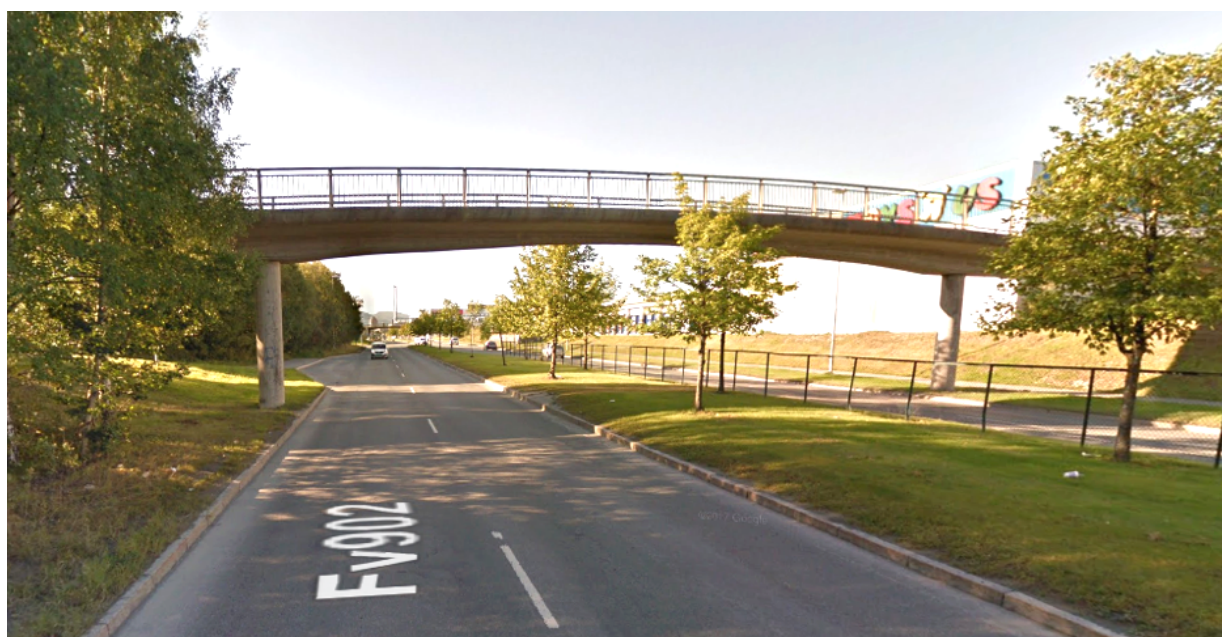
Figur 9: Overgangsbro sør for Prosjektkrysset (Google Maps)
