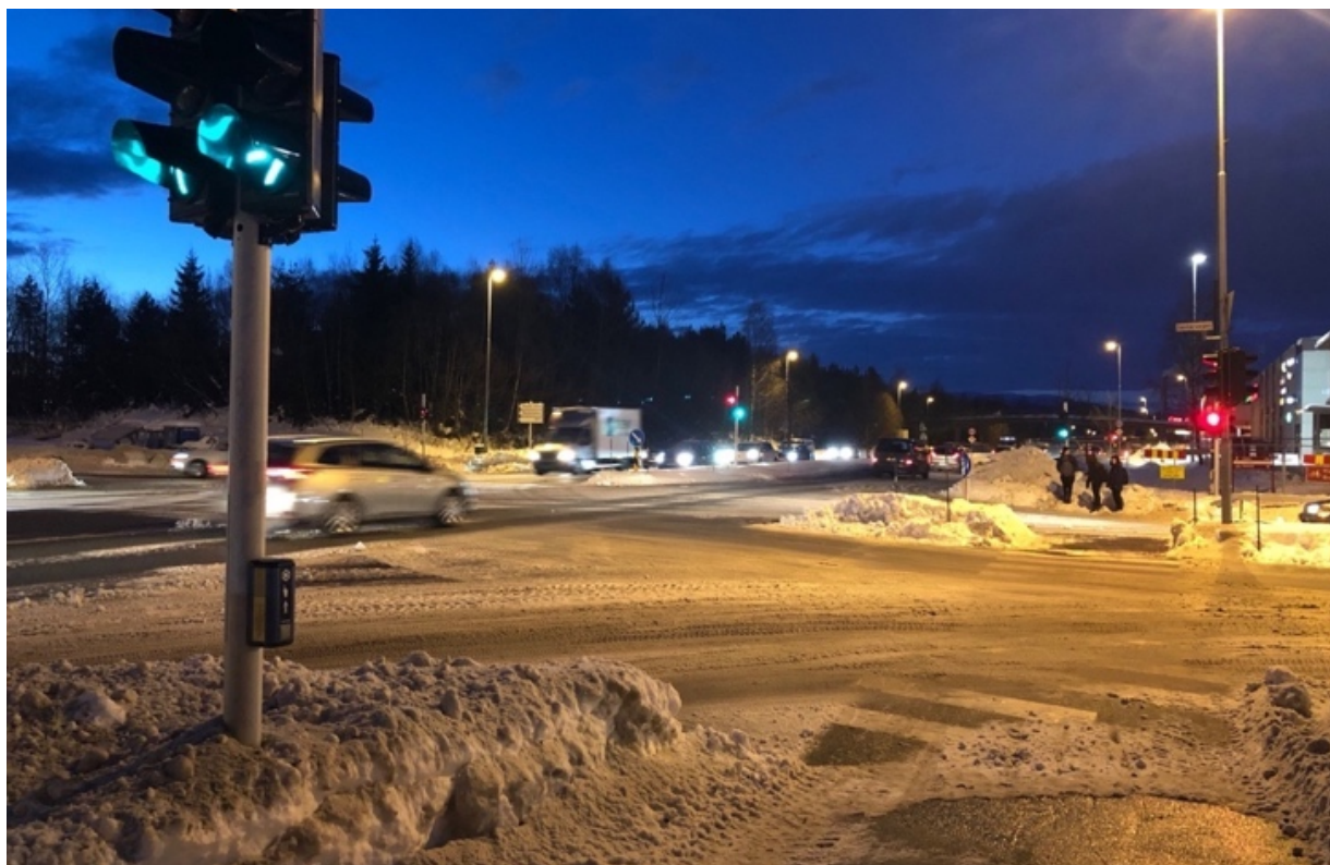
Figur 1: Prosjektkrysset sett mot sør (bilde tatt på befaring)
