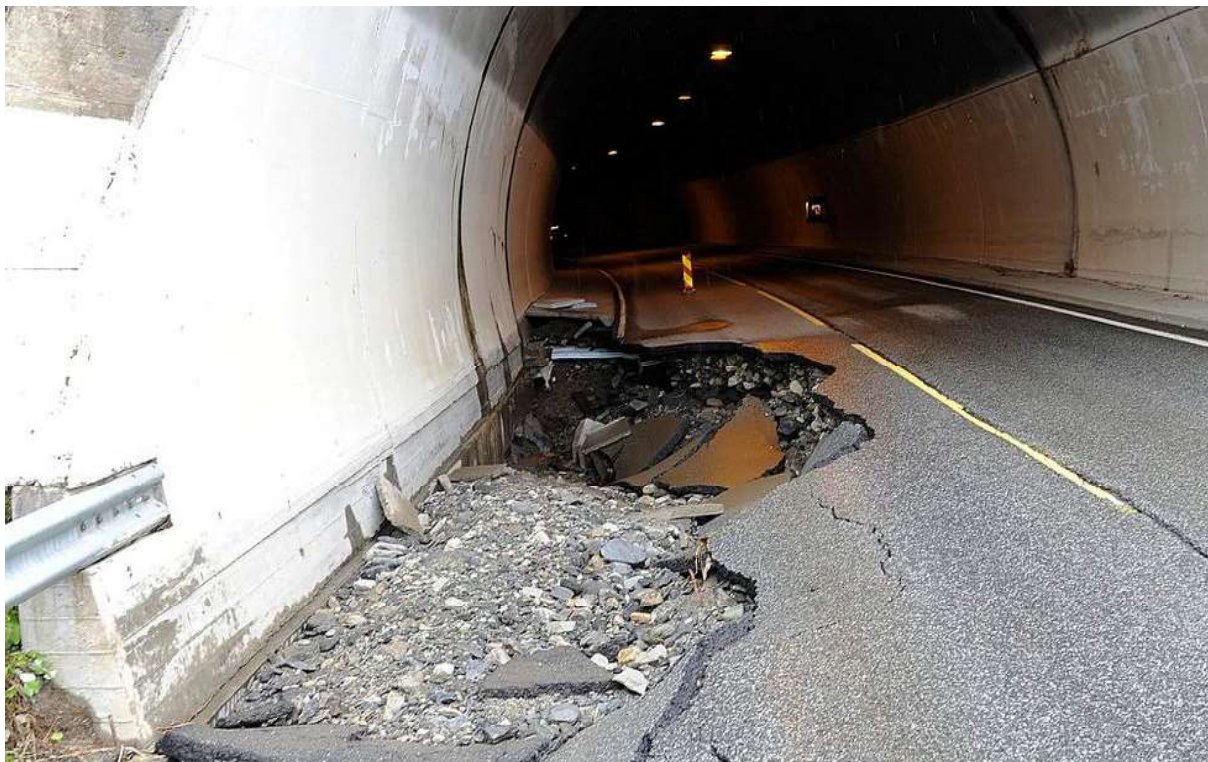
Slik så det ut i Svølgjatunnelen 2011 (Foto: Adresseavisen)
