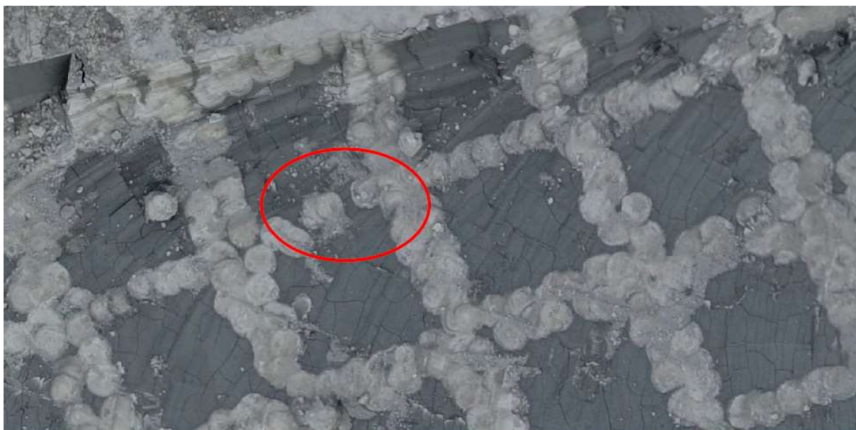
Figur 36: Bilde tatt fra drone for kontroll av KC-peler. Bilde: Statens Vegvesen
