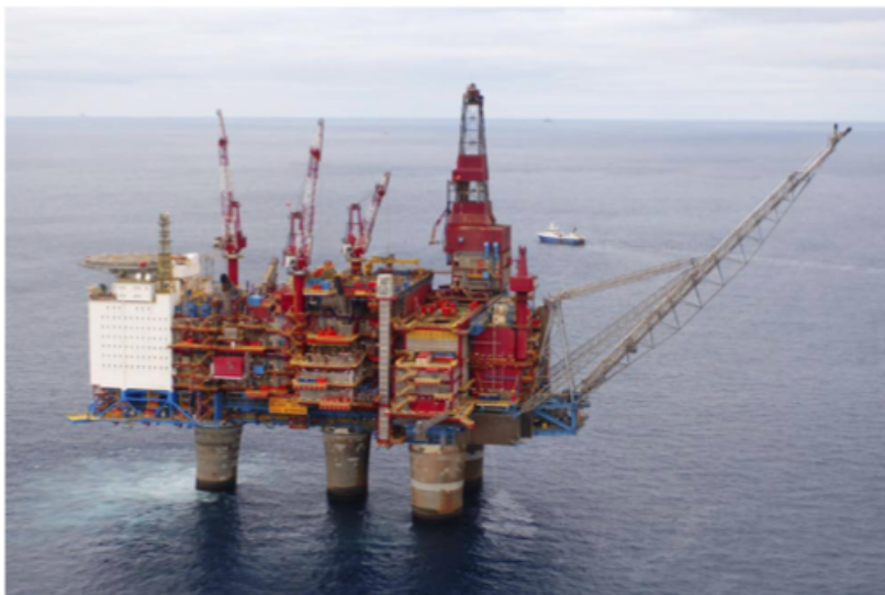
Figur 2.5: Gullfaks C-plattformen (Kilde: Ref-1, s. 52).
