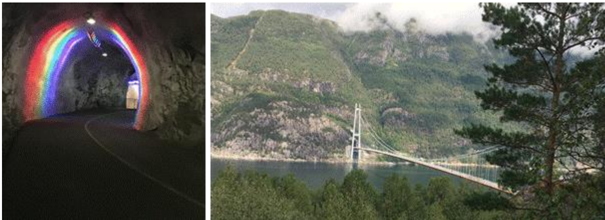
Bilde 6-1: Bilde av belysning på gang og sykkelveg i tunnelen på Bu-siden (venstre) og Hardangerbrua sett fra Buplatået (høyre)
