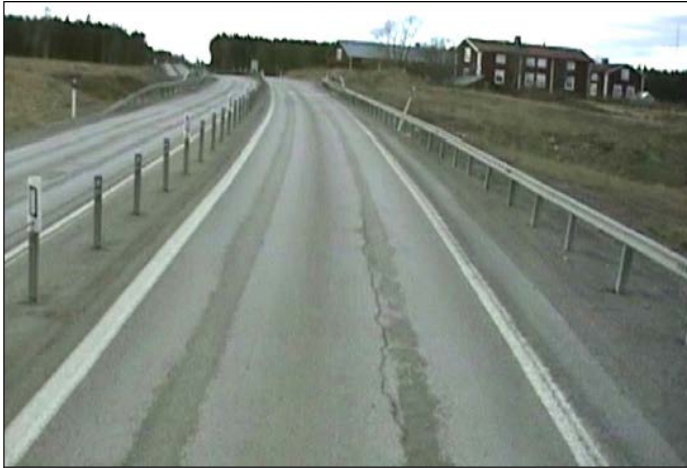
Figur 11 Hvordan smal veg med rekkverk på begge sider kan gjør at trafikken blir liggende i akkurat samme spor som øker sporutviklingen (Saarenketo og Varin 2014.)
