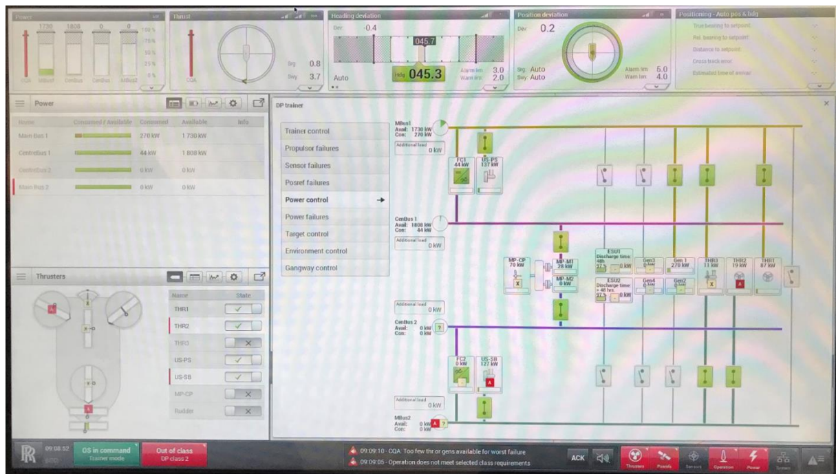
Figur 52. DPS alarmsituasjon 2, (Rolls-Royce Marine, testlab).
