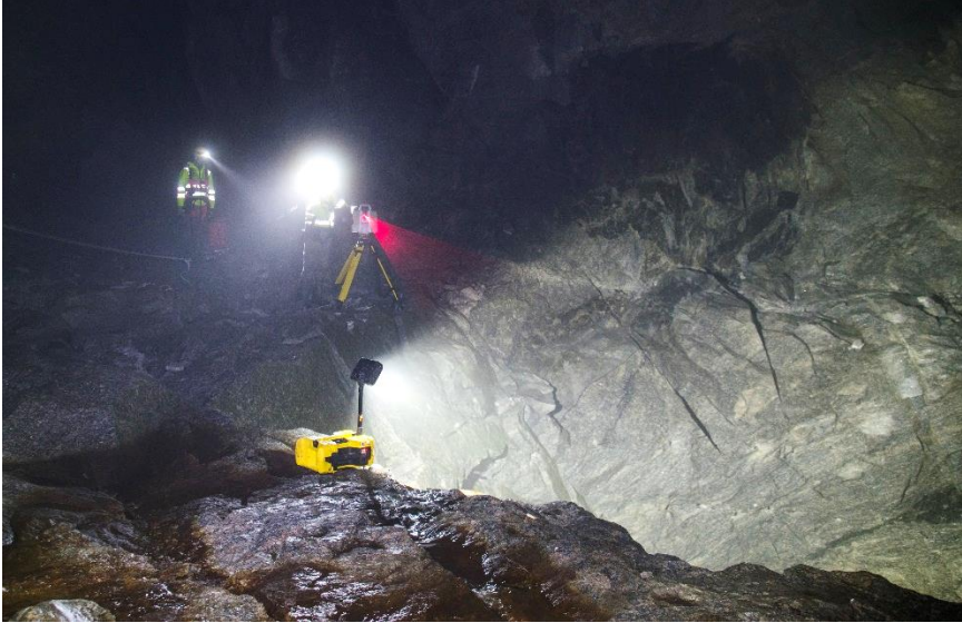
Fig. 7. Fra tunnelskanning øvre del av svingekammeret ved Roskrepp kraftverk (foto: Livia Pitorac).
