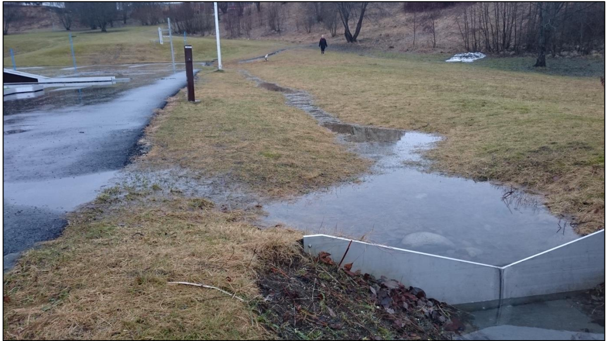
Figur 6: Innløp Risvolla regnbed. Skarpkantet V-overløp med 150° vinkel. Gresskledd vannveg i bakgrunn. Befaring 19.02.17.
