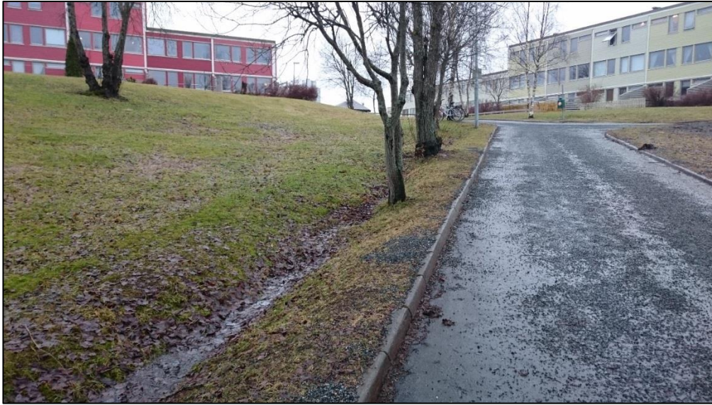
Figur 44: Synlig bekk i grøften til venstre ved punkt B. Stemmer med modellert vannstrøm i HEC-RAS. Befaring 19.02.17.
