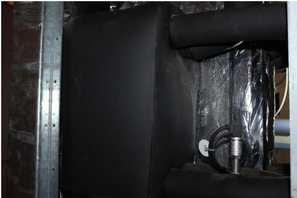
Figur 38 Isolering av sugegassvarmeveksler
