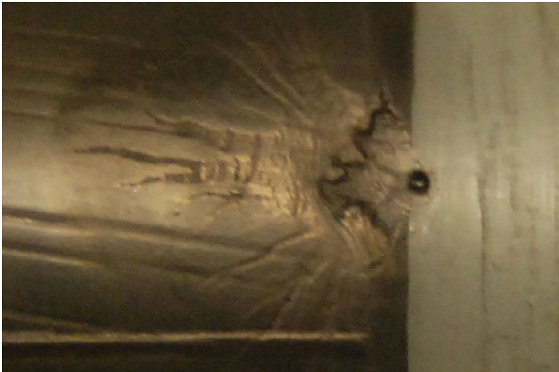
Figur 4.21: Gjennomslagsområde i Kabelskjøt A. Gjennomslaget har oppstått i området mellom halvleder og isolasjonen. Det er tydelige spor av utladninger langs den ytre halvlederen.
