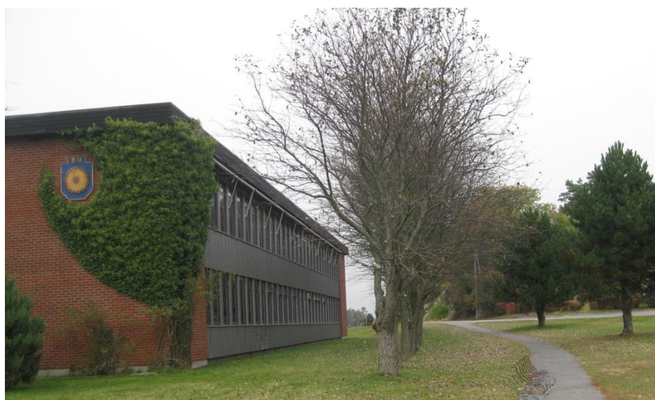
Figur 19: Hovedbygningen ved Brunla ungdomsskole
