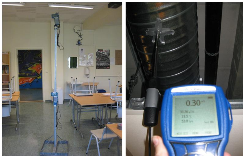
Figur 27: Måling av lufthastighet i klasserom og avtrekkskanal
