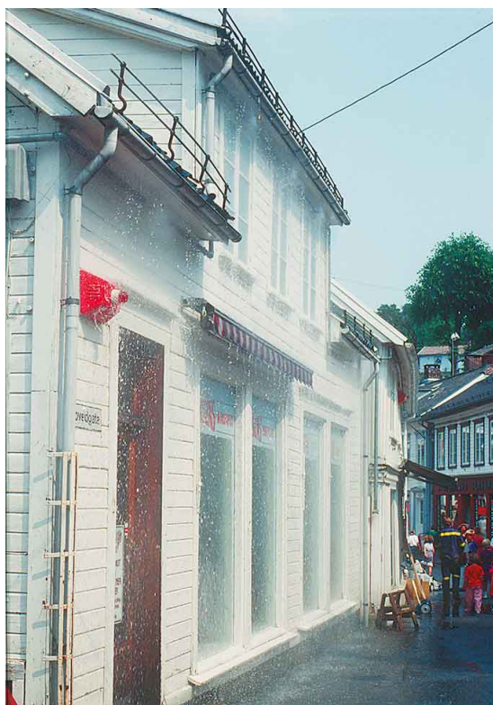
Figur 7: Fasadesprinkler (SINTEF Byggforsk, 2007).
