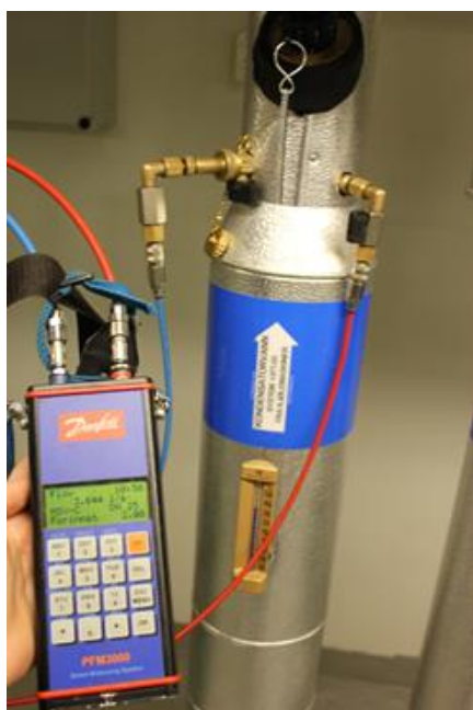
Figur 16 Vannmåling over innreguleringsventil
