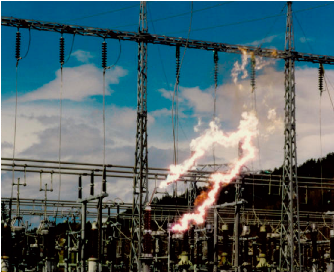
Lysbue ved overslag – med feilskriverdiagram.
