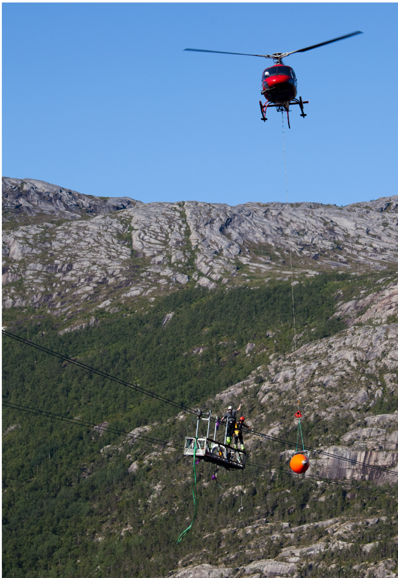
Montasje av flymarkør på fjordspenn.
