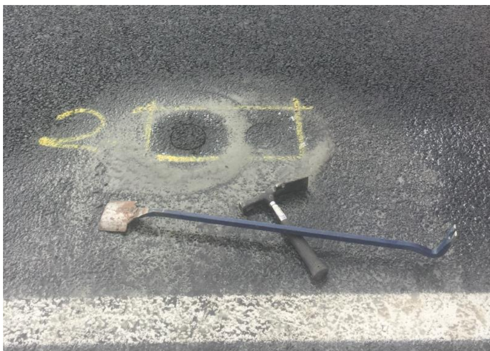
Figur 6 – Bilde av uttaking av borkjerneprøve (Foto: Trond Østen Okt. 2017)
