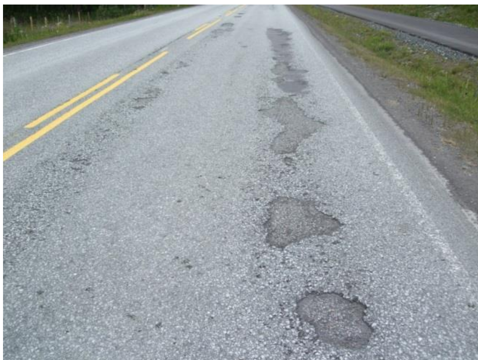
Figur 4 – Høyt hulrom gir steinslipp i hjulsporene. (Statens vegvesen, 2015a)
