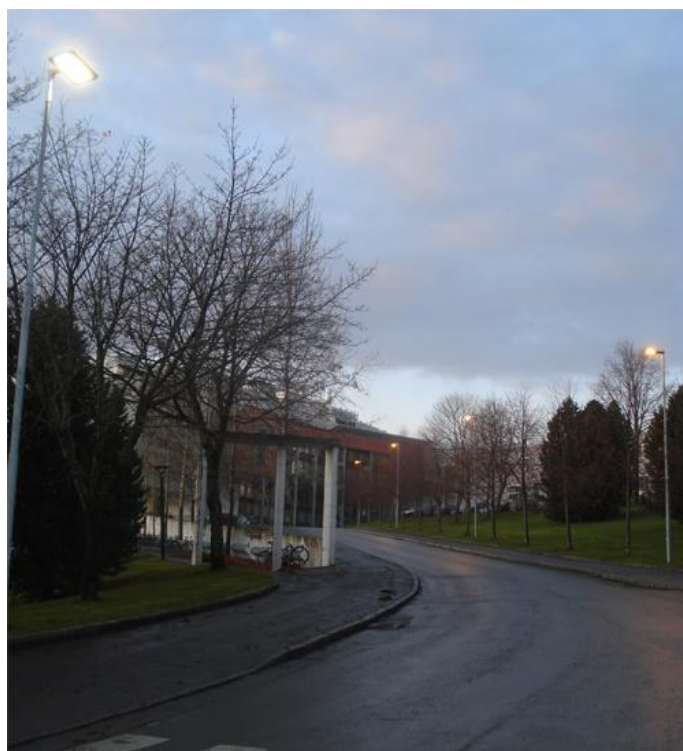
Figur 4-1: Den øvre delen av veglysanlegget i Høgskoleringen
